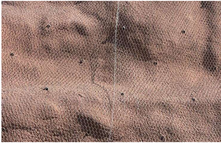
Figura 68 - Tubulações para drenagem (foto de minha autoria)
