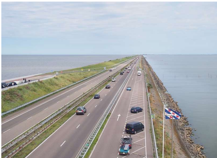
Figura 86 - O dique Afsluitdijk, nos Países Baixos [132].
