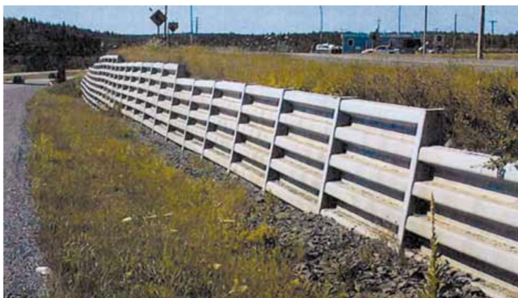
Figura 70 - Muros de Caixa de Aço [120].
