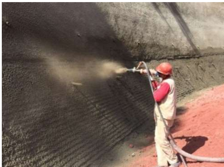
Figura 71 - Grampeamento do Solo [104].
