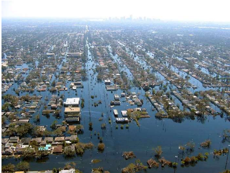
Figura 31 - Inundação em Nova Orleães, nos EU [74].
