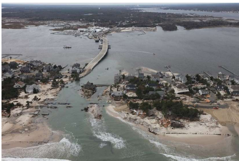
Figura 32 - Inundação devido ao Furacão Sandy, na costa de Nova Jersey, 2012 [75].
