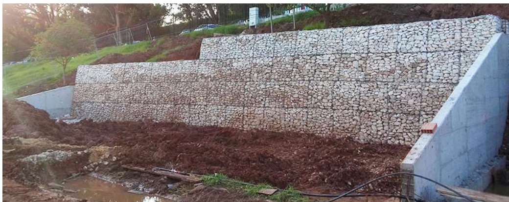
Figura 73 - Muros de gabião [122].
