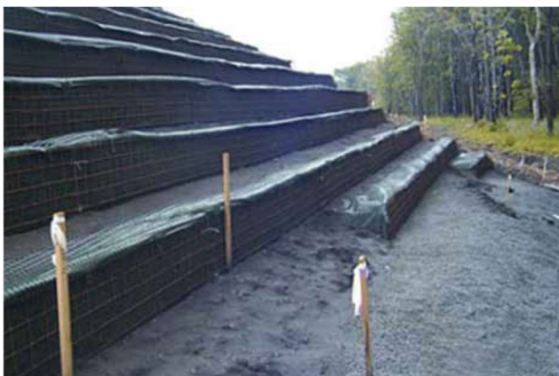
Figura 67 - Modelo esquemático e exemplo de enchimento com material leve [120].
