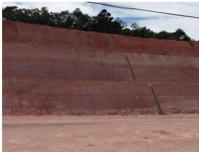
Figura 54 - Retaludamento _Alteração da geometria do talude [104].
