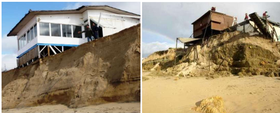
Figura 24 - Erosão na zona costeira, Costa da Caparica (imagem da direita), Esmoriz (imagem da esquerda), Portugal [59], [60].
