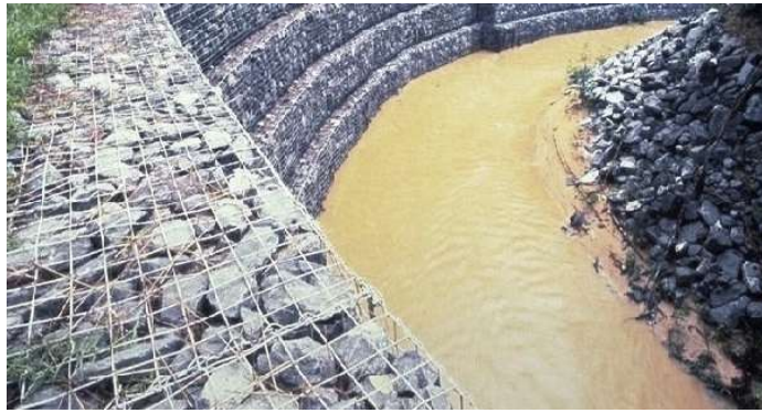
Figura 56 - Muro de gabião [105].
