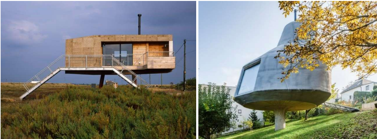
Figura 88 - Palafitas em aço galvanizado, Reino Unido (direita) e Palafitas de betão armado, Republica Checa (esquerda) [134].
