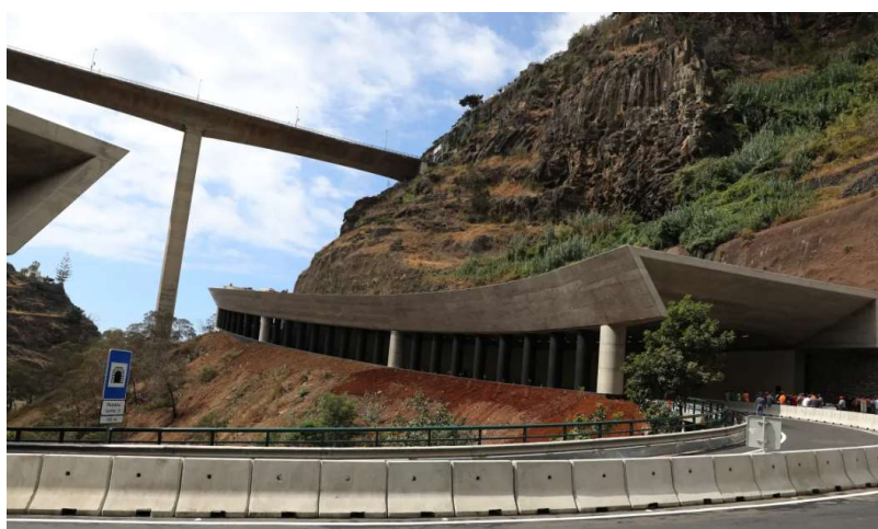
Figura 64 - Túnel aberto, Funchal, Ilha da Madeira [119]
