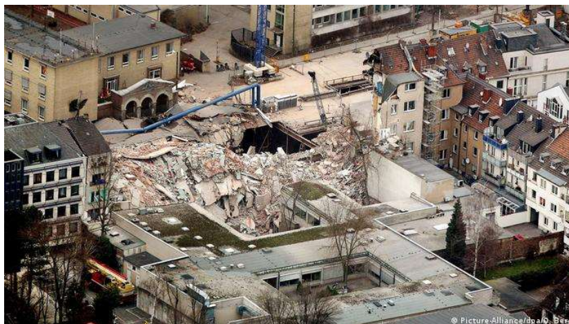
Figura 29 - Colapso de uma parede derruba edifício, Colónia [66].
