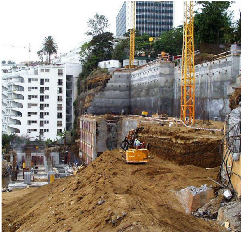
Figura 65 - Contenção com ancoragens e pregagens definitivas, Hotel Savoy Royal, Funchal, 1990
