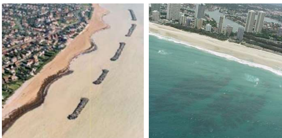
Figura 79 - Quebramar destacado emerso (esquerda) e submerso (direita) [127].
