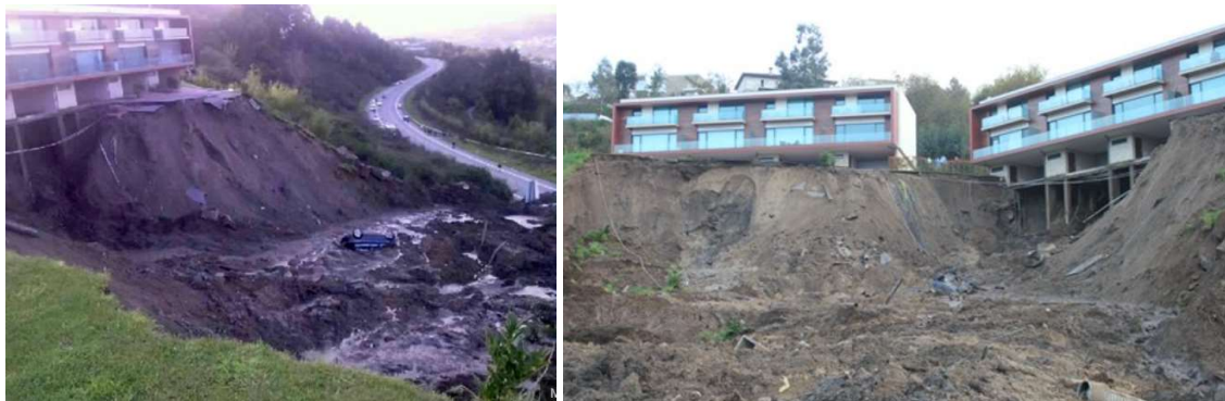
Figura 25 - Deslizamento de terras, Guimarães [61].
