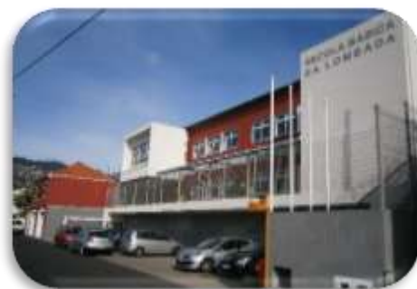
Figura 43 - EB1/PE do Areeiro e Lombada - Edifício da Lombada
