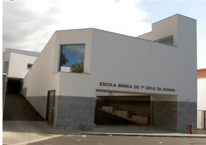
Figura 17. Escola Básica do 1ºCiclo com Pré-Escolar da Achada.
