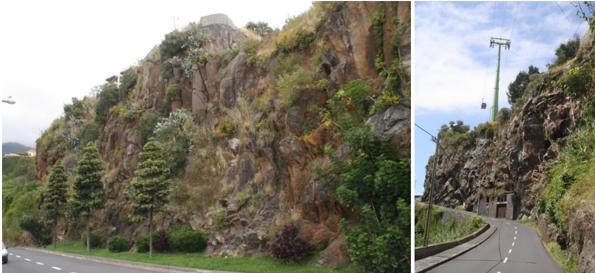
Figura 6.2: Vista geral sobre os taludes (A) Achada e (B) Peugeot
