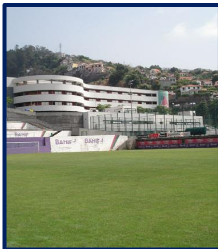
Figura 74 - Colégio do Marítimo
