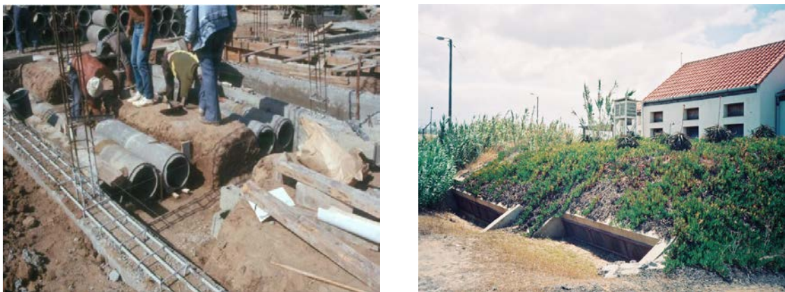
Figura5.14 – Pormenor da colocação dos tubos enterrados (à esquerda) e entrada de ar do sistema de tubos (à direita) (Autor: C. Magro).
