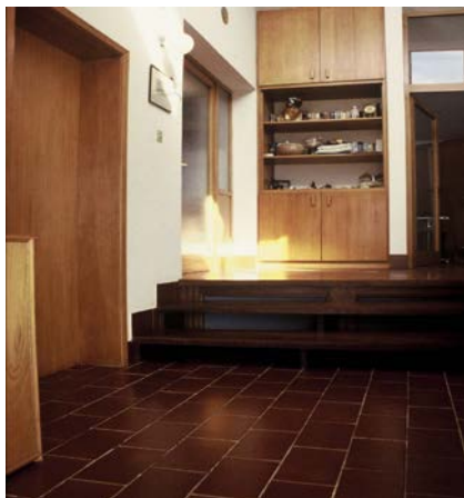
Figura5.9 – Saída de ar do sistema de tubos enterrados para o interior da habitação (sob as escadas em madeira) (Autor: C. Magro).
