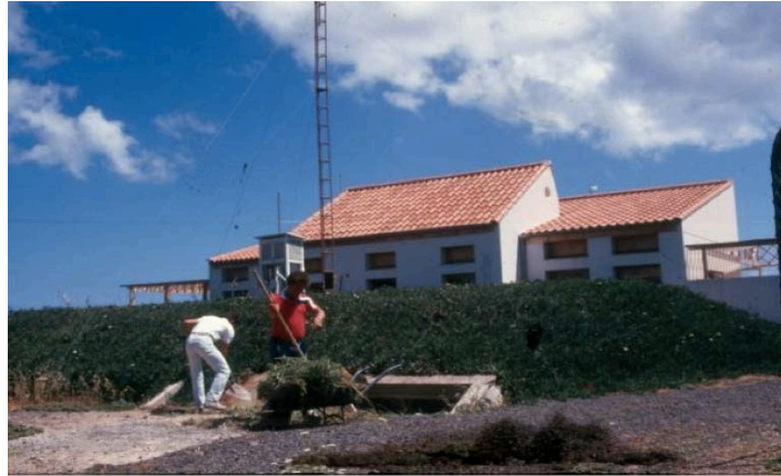
Figura5.12 – Fachada Norte da casa Solar Passiva Porto Santo parcialmente enterrada (Autor: C. Magro).
