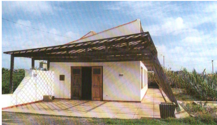
Figura5.13 – Pérgola sombreando a fachada Poente (fonte: Gonçalves et al, 1997).
