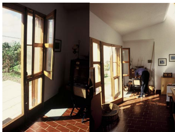
Figura5.5 – Caixilharias com vidros duplos (Autor: C. Magro).
