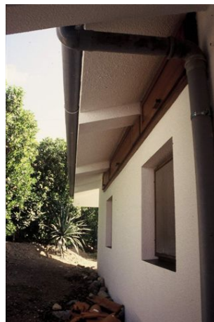
Figura5.4 – Fachada Norte parcialmente enterrada e com aberturas de ventilação da cobertura (Autor: C. Magro).
