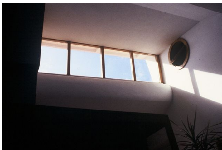
Figura5.2 – Clarabóia na cobertura da moradia Schäfer para promoção dos ganhos solares (Autor: C. Magro).
