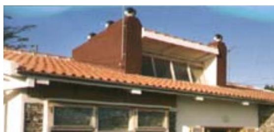
Figura5.8 – Pormenor dos beirados salientes na fachada sul, das chaminés solares na moradia Schäfer pintadas com uma cor escura para uma maior absorção do calor proveniente da radiação solar e da clarabóia com pala de pequena dimensão (Autor: C. Magro).
