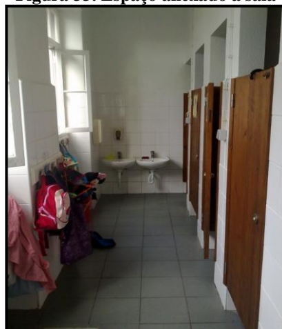
Figura 33. Espaço anexado à sala
