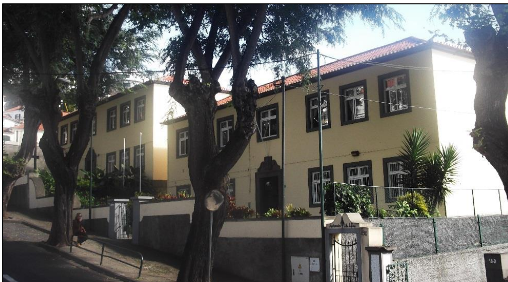
Figura 7. Fachada da Escola EB1/PE (edifício 60 na parte superior e o edifício 59 na parte inferior).
