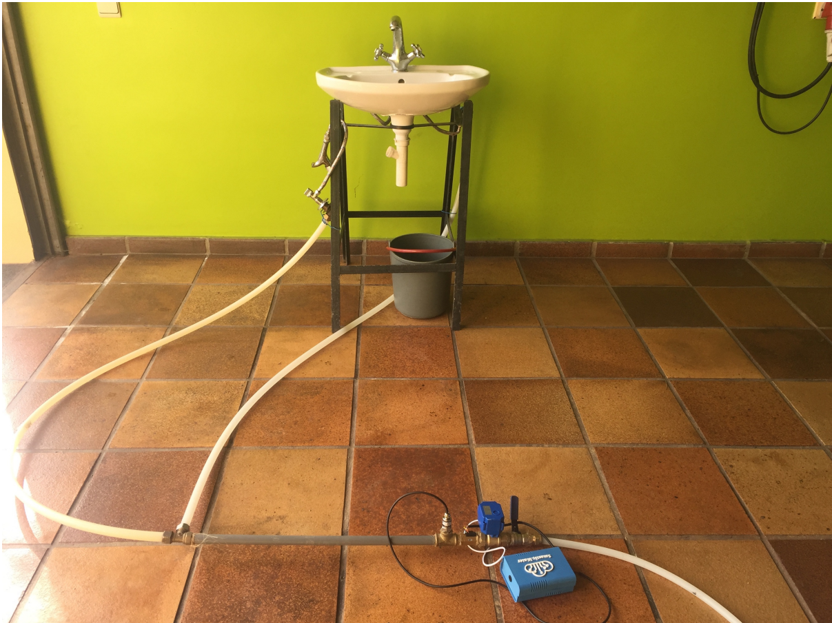
Figura 65: Circuito de teste de fugas.
