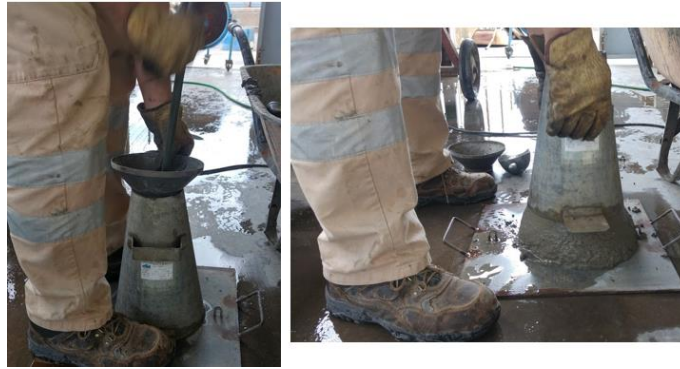
Figura 34 - Execução do ensaio de abaixamento
