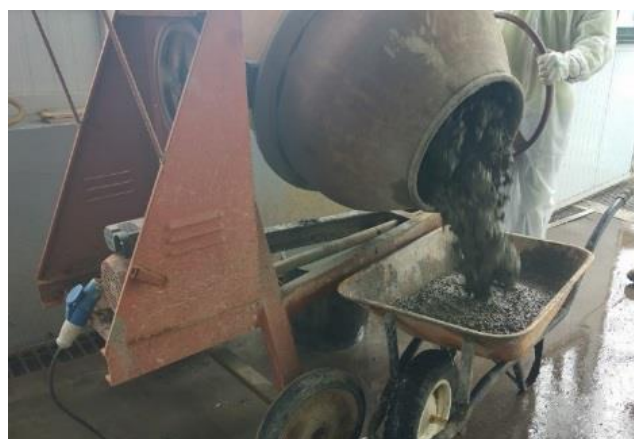
Figura 33 - Descarga do betão fresco
