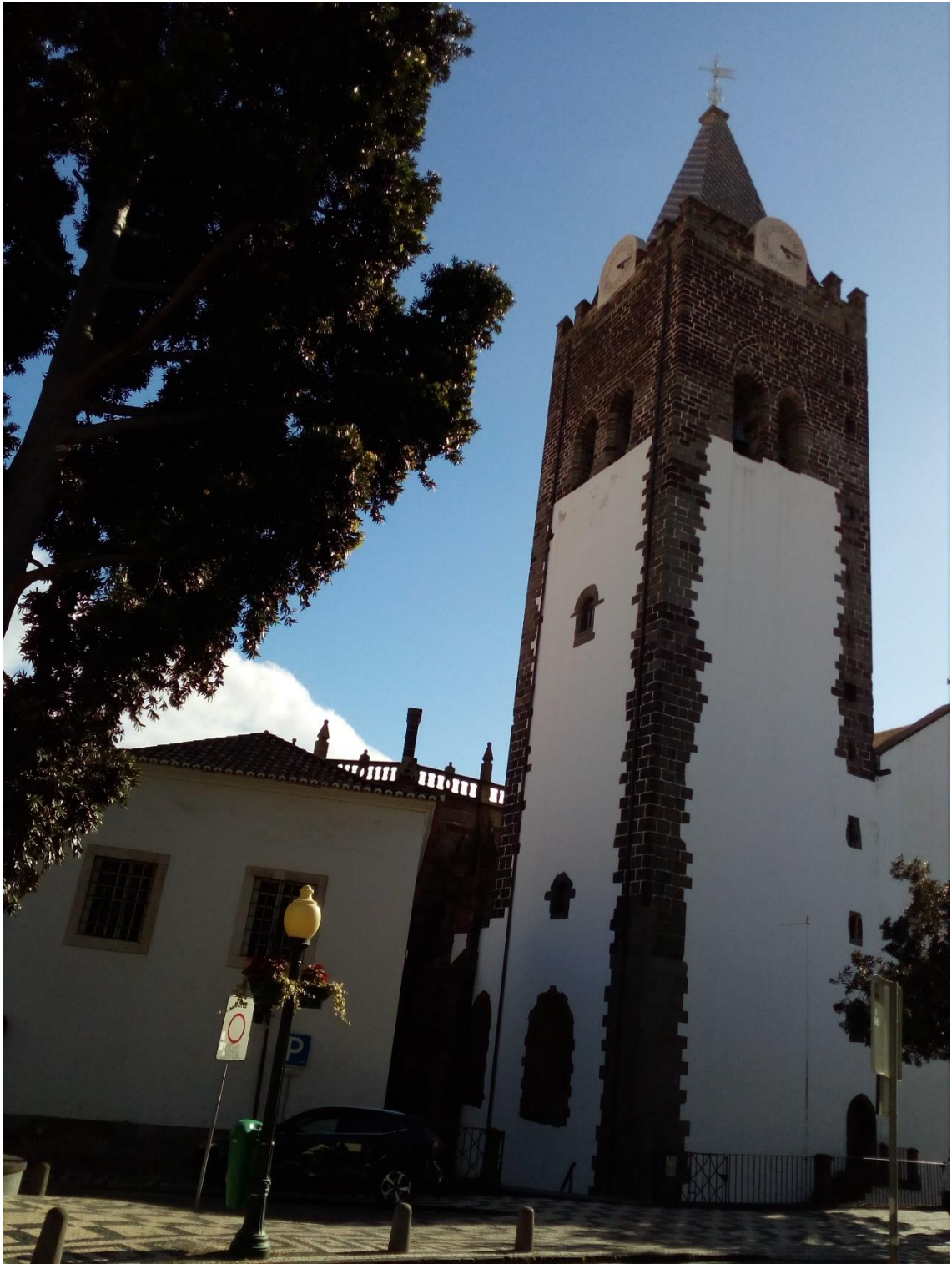
Torre da Igreja da Sé.
