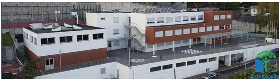
Figura 52 – Escola EB1/PE de Câmara de Lobos
