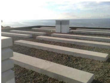
Figura 67 - Colocação de vigas (Gonçalo Camacho, 2010)
