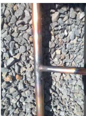
Figura 69 - Soldadura em tubo de cobre (Gonçalo Camacho, 2010)
