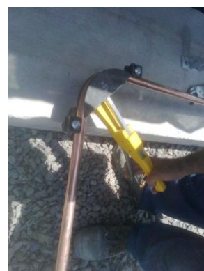
Figura 71 - Formação de uma curva a 90º em tubagem de cobre (Gonçalo Camacho, 2010)
