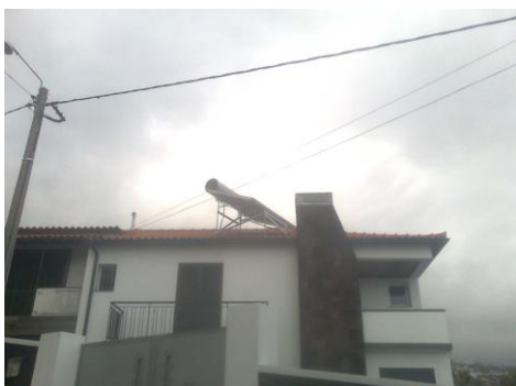
Figura 26 - Habitação com sistema solar tipo termossifão (Gonçalo Camacho 2010)
