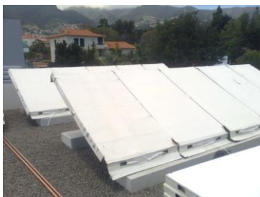
Figura 70 - Colocação dos painéis (Gonçalo Camacho, 2010)
