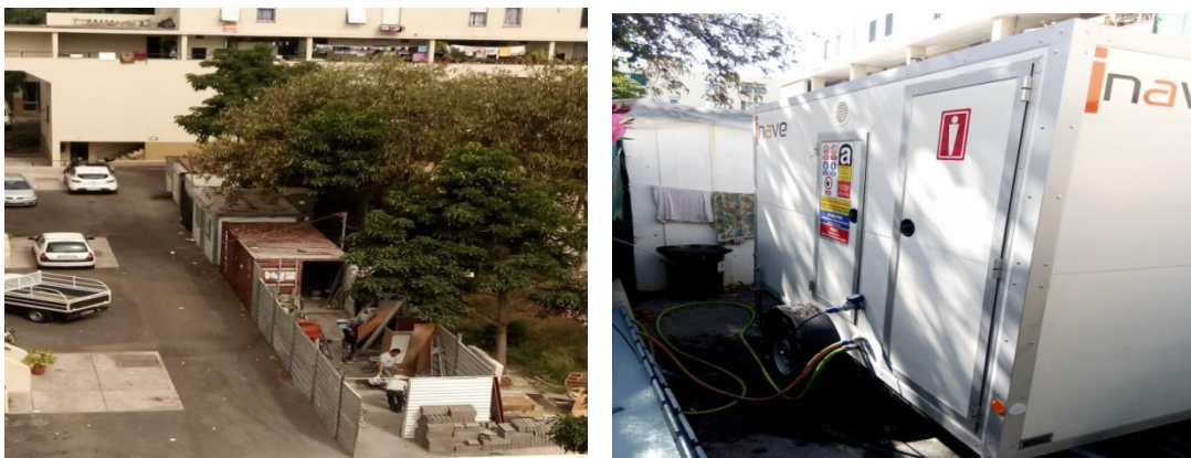
Figura 5.17 – Estaleiro e Cabine de Descontaminação Móvel.
