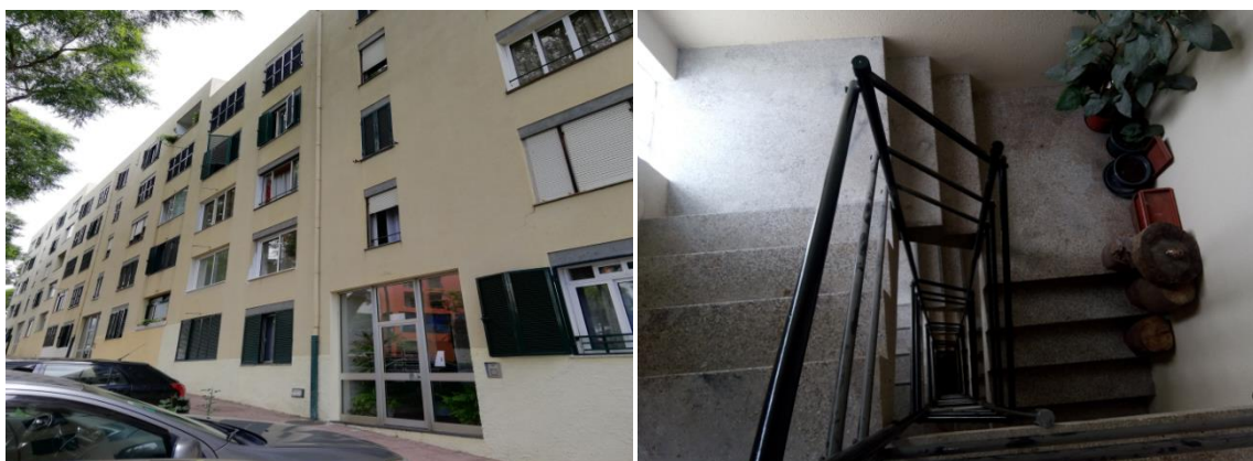
Figura 5.16 – Fachada e interior do prédio n.º 164.
