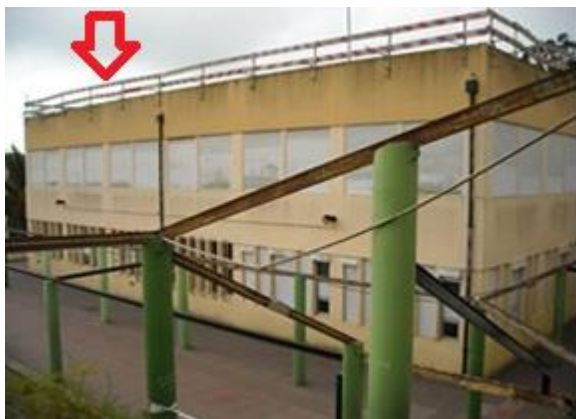
Figura 5.2 – Cobertura da Escola.
