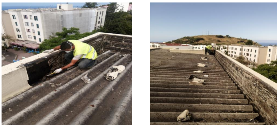
Figura 5.18 – Trabalhador a remover impermeabilização da cobertura.
