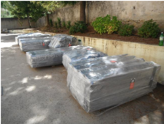
Figura 5.12 – Resíduos palatizados de Fibrocimento.
