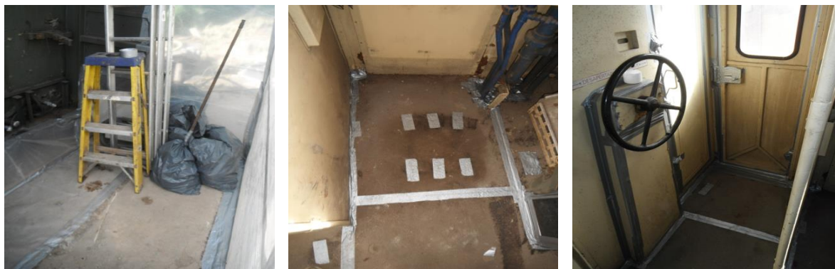
Figura 5.24 – Pavimento revestido de manga polietileno e zona da cabine estanque.
