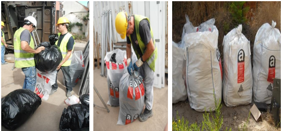
Figura 5.32 – Processo de Ensacamento de resíduos de amianto friável.
