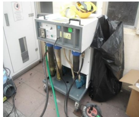
Figura 5.6 – Filtragem de águas residuais com amianto (utilizado pela camara descontaminação).
