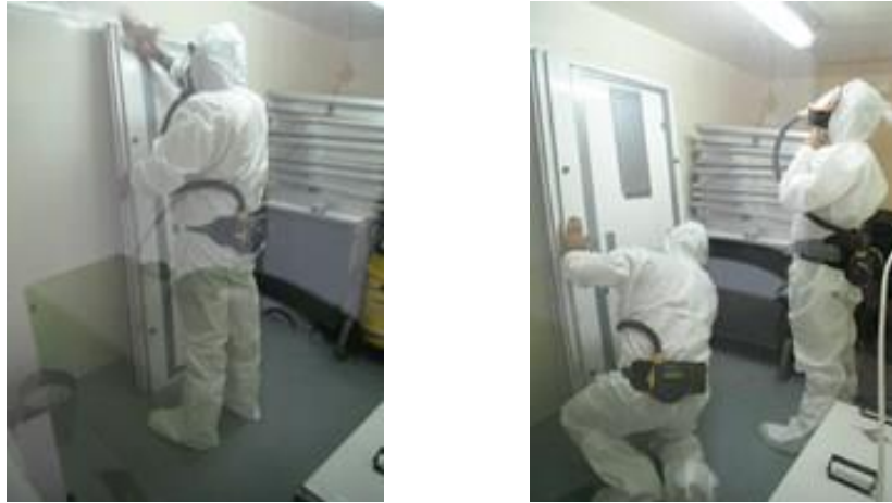
Figura 5.14 – Limpeza dos Painéis da Câmara de Descontaminação
