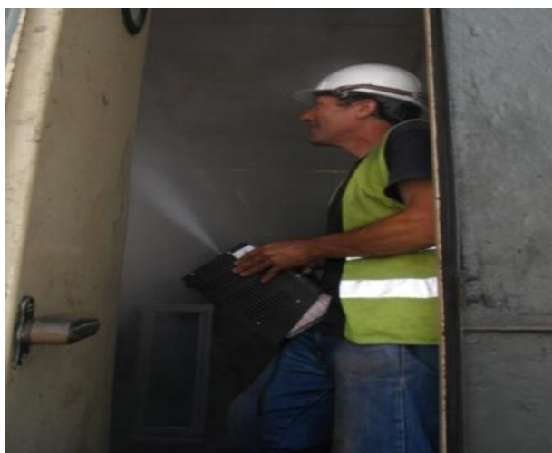
Figura 5.28 – Teste de fumo a verificar a existência de fugas em zonas confinadas.
