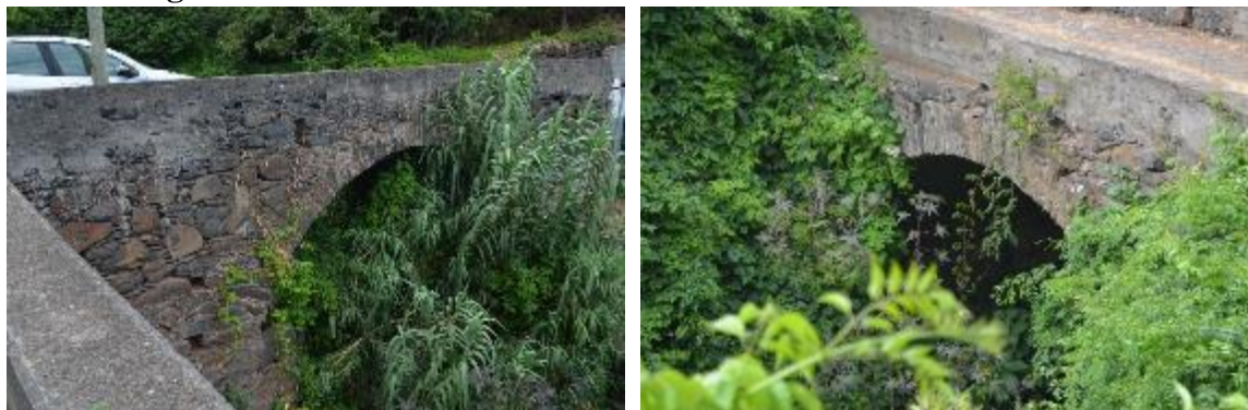
Fotografia 1 – Alçado Jusante (esq.); Alçado Montante (dir.);
