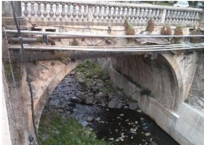
Fotografia 1 – Alçado Jusante (esq.);
