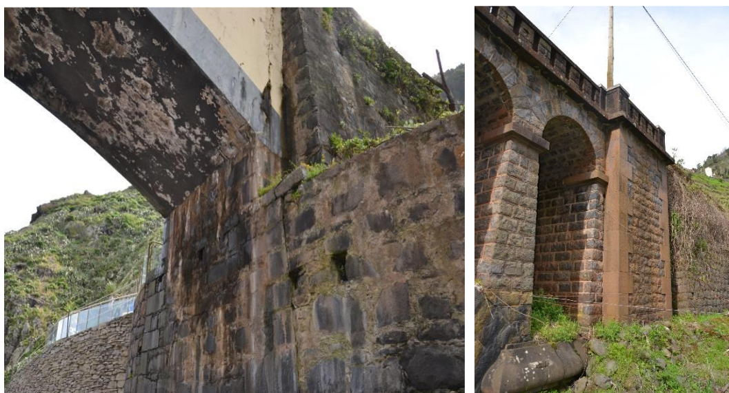
Figura 18 – Encontro da Ponte ER101 São Jorge (esq.) e Ponte Ramal do Caminho Real Nº23 (dir);
