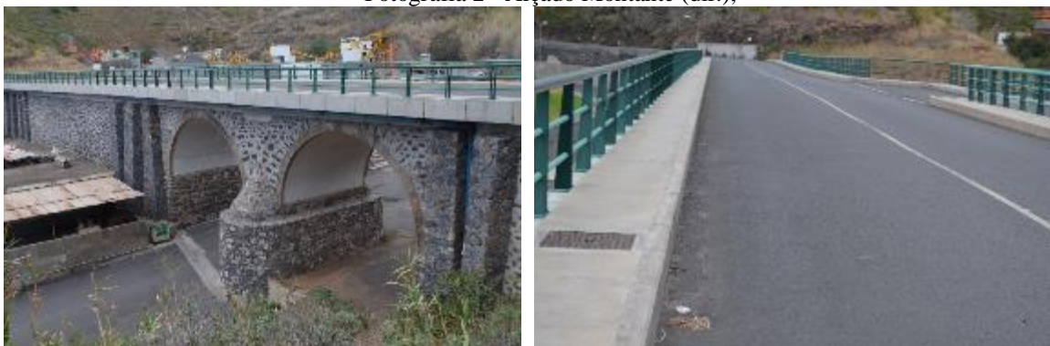
Fotografia 3 – Pilar, Murto Timpano e Arco (esq.) Pavimento, Passeio e Guarda Corpos (esq.);
