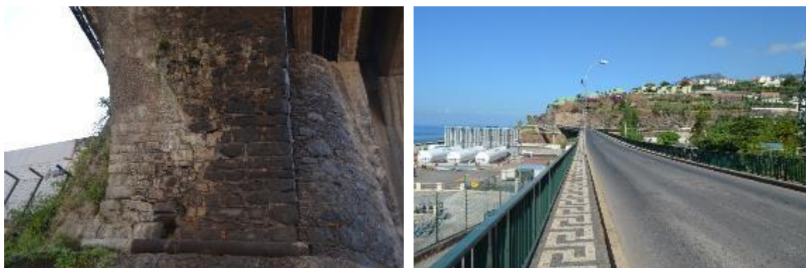
Fotografia 3 – Encontro (esq.); Pavimento, Passeio, Guardas Corpos Metálicos (dir.);
