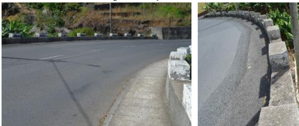
Fotografia 3 – Pavimento e Passeio (esq.); Guarda Corpos (dir.);
