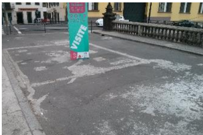
Fotografia 3 – Pavimento, Passeio e Guarda Corpos (esq.);
