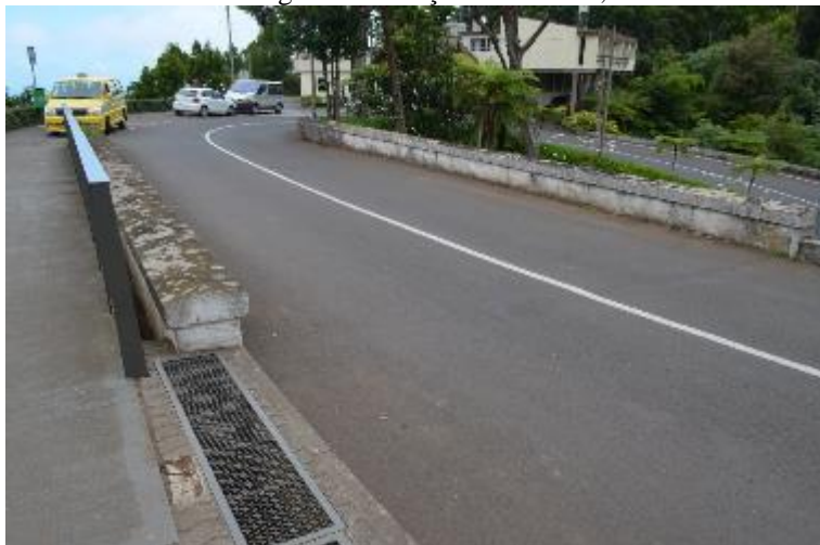
Fotografia 3 – Pavimento, Guarda Corpos;
