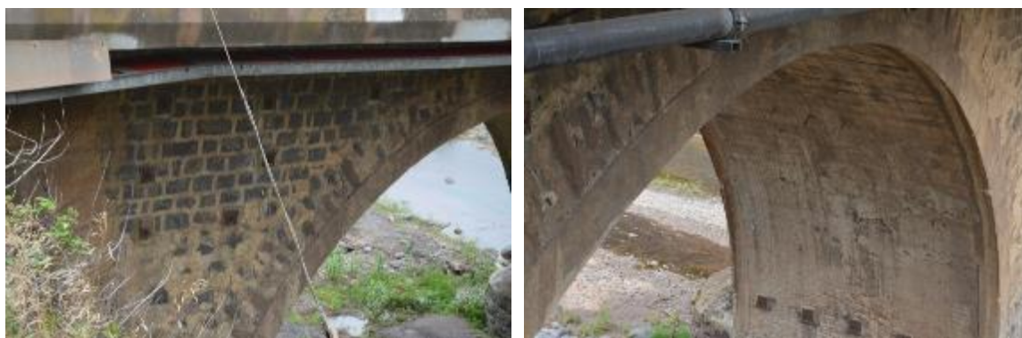
Fotografia 2 – Muro Tímpano (esq.); Extradorso e Intradorso do Arco (dir.);
