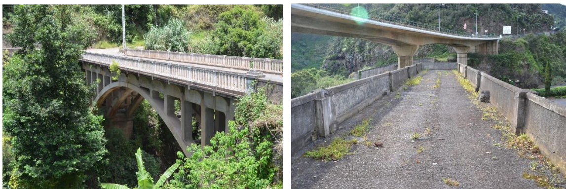
Figura 8 – Ponte em arco de betão armado (esq.); Ponte 21 de Junho (dir.);
