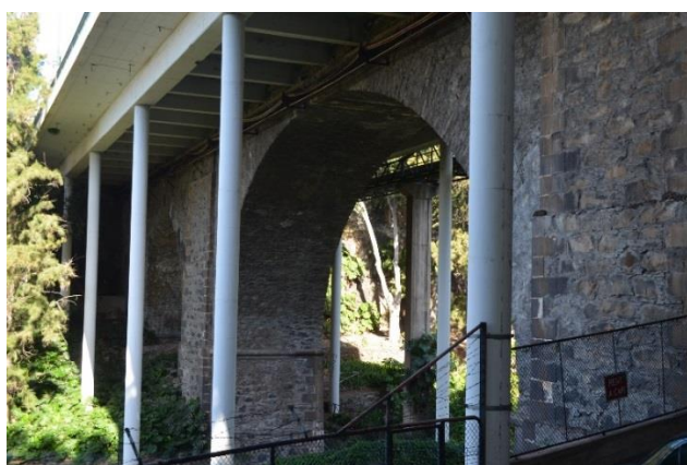
Figura 90 – Pilares e laje;
