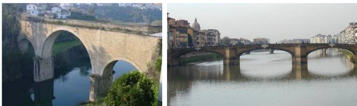
Figura 6 – Ponte de Caninhas (Cifães, Portugal), arcos de volta perfeita (esq.) [3]; Ponte Santa Trinita (Florença, Itália) com arcos abatidos (dir.) [9];
