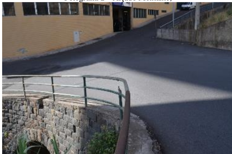
Fotografia 3 – Pavimento, Guarda Corpos;
