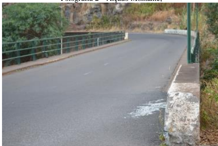
Fotografia 3 – Pavimento, Guarda Corpos;
