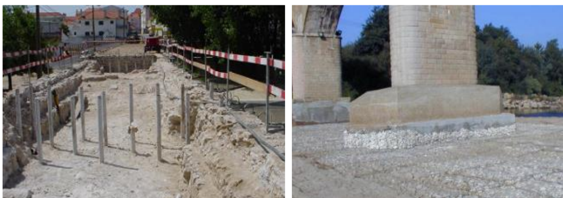
Figura 46 – Aplicação de cortina de micro-estacas (esq.) [12]; Cintagem e proteção do apoio (dir.) [7];
