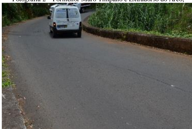
Fotografia 3 – Pavimento e Guarda Corpos;
