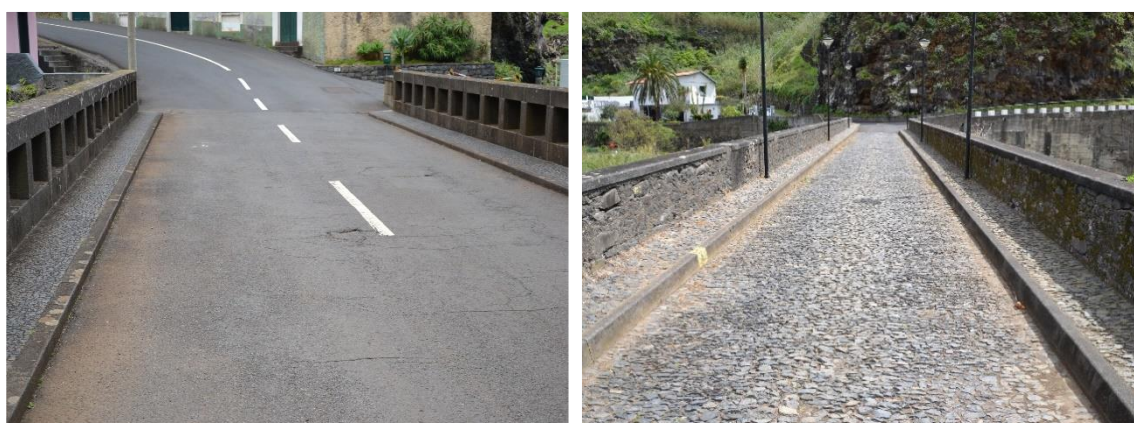
Figura 21 – Pavimento betuminoso, Ponte Ribeira da Janela (esq.); Pavimento constituído por unidades de alvenaria, Ponte Estrada Dr. João Abel (dir.);
