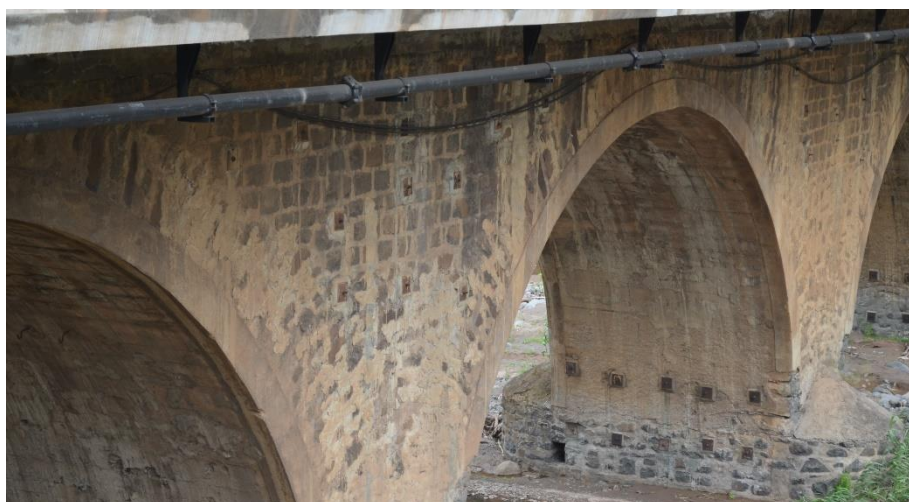
Figura 87 – Tirantes nos muros de tímpano;
