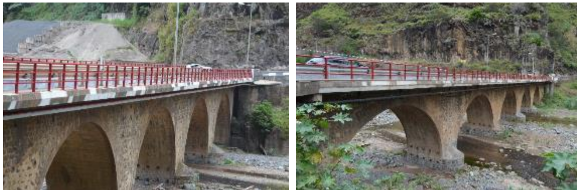
Fotografia 1 – Alçado Jusante (esq.); Alçado Montante (dir.);
