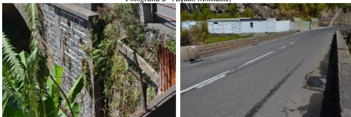
Fotografia 3 – Encontro (esq.); Pavimento e Guarda Corpos (dir.);
