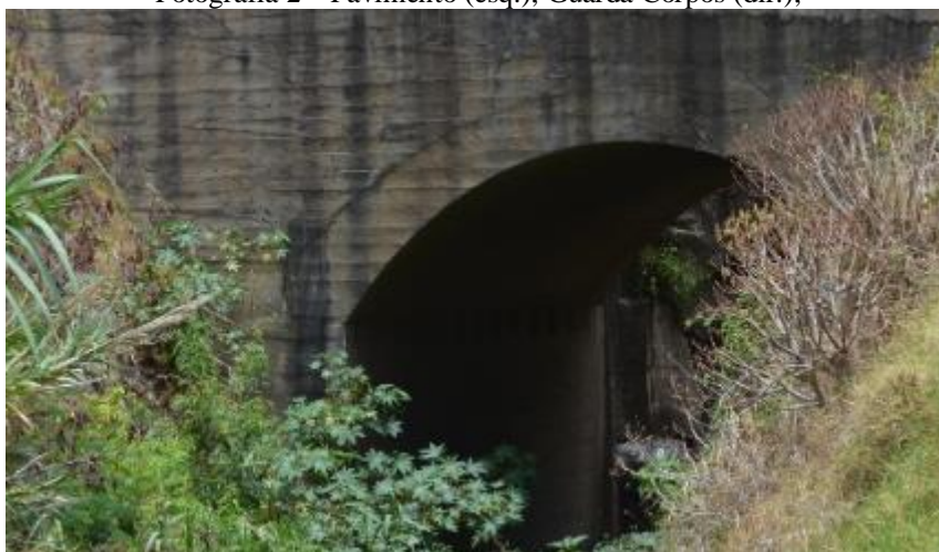
Fotografia 3 – Extradorso do Arco, Muro Tímpano, Encontro a Montante;
