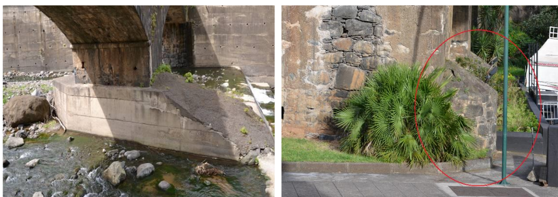
Figura 20 – Talha-mar da Ponte Estrada Dr, João Abel em Betão (esq.); Talhante da Ponte do Faial (dir.);
