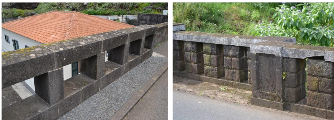
Figura 22 – Guardas laterais de alvenaria de pedra, Ponte Ribeira da Janela (esq.) e Ponte ER101 São Jorge (dir.);
