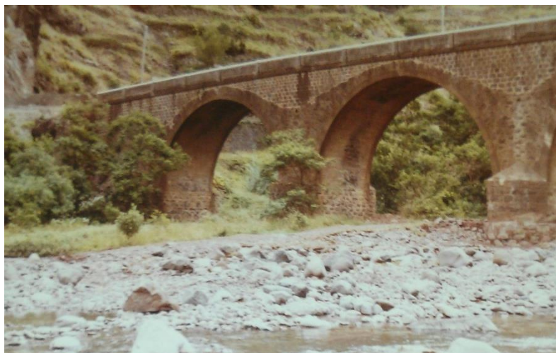
Figura 83 – Ponte da Ribeira da Metade sem intervenções;
