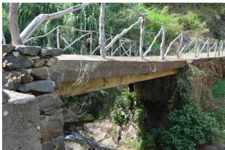
Fotografia 1 – Alçado Jusante (esq.);
