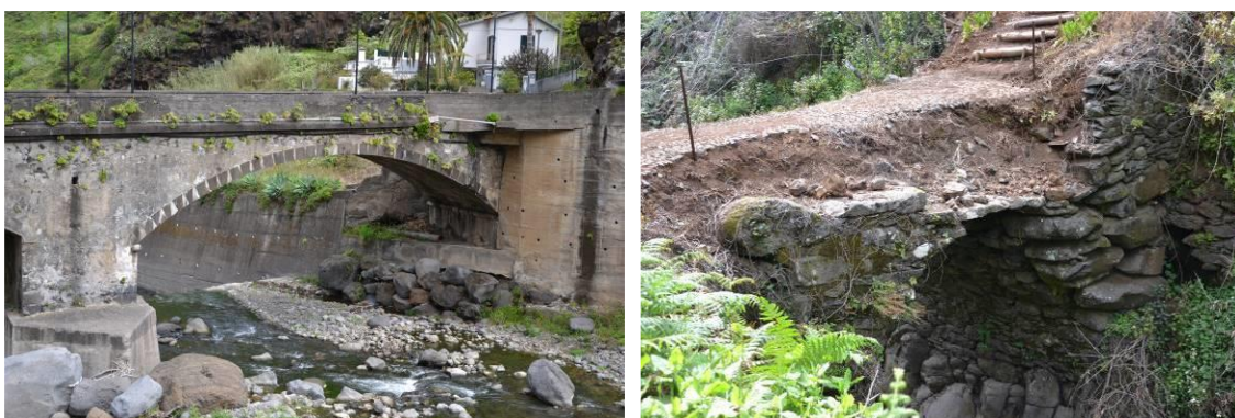
Figura 14 – Arco da Ponte Estrada Dr. João Abel (esq.); Arco de uma ponte pedonal (dir.);
