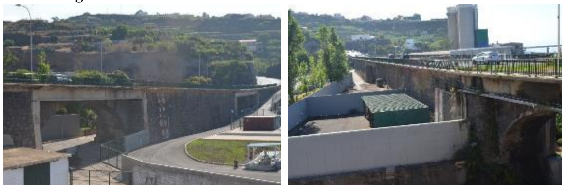
Fotografia 1 – Alçado Jusante (esq.); Alçado Montante (dir.);
