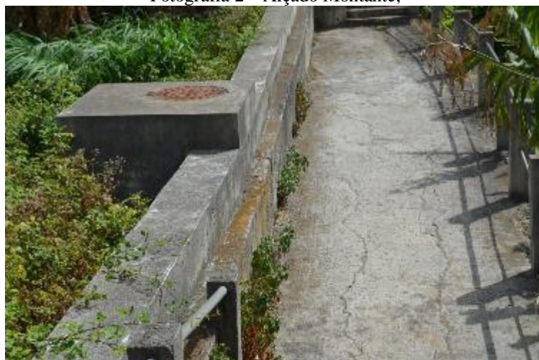
Fotografia 3 – Pavimento e Guarda Corpos;
