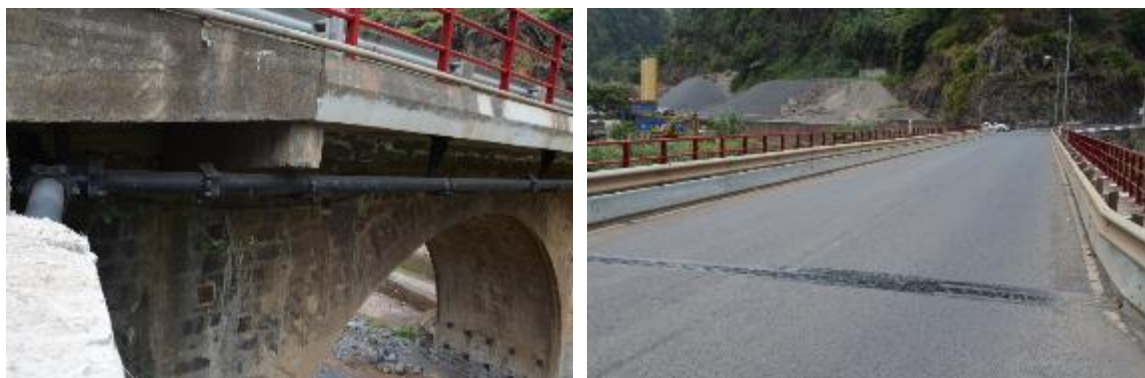
Fotografia 3 – Vigas de betão armado (esq.); Pavimento, Guardas Corpos (dir.);
