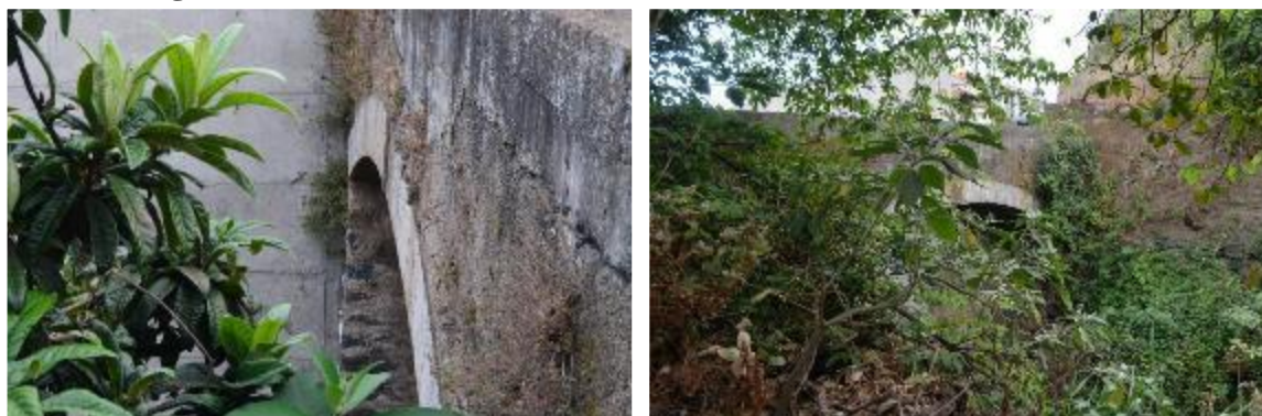
Fotografia 1 – Alçado Jusante (esq.); Alçado Montante (dir.);
