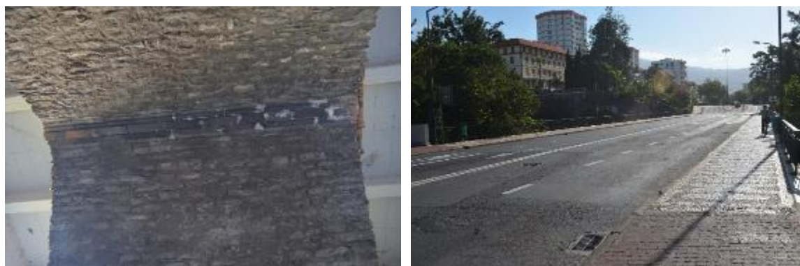
Fotografia 3 – Intradorso do Arco Ogival (esq.); Pavimento, Passeio e Guarda Corpos (dir.);
