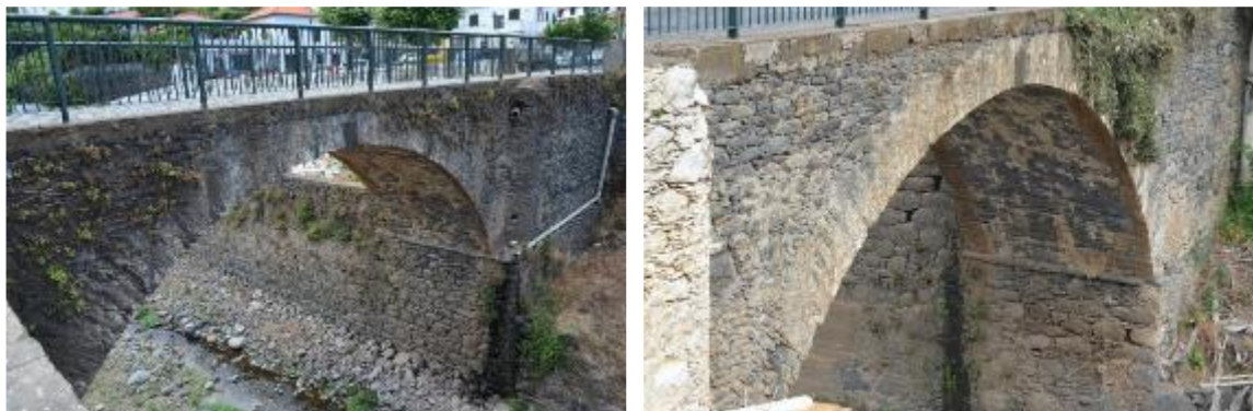
Fotografia 1 – Alçado Jusante (esq.); Alçado Montante (dir.);
