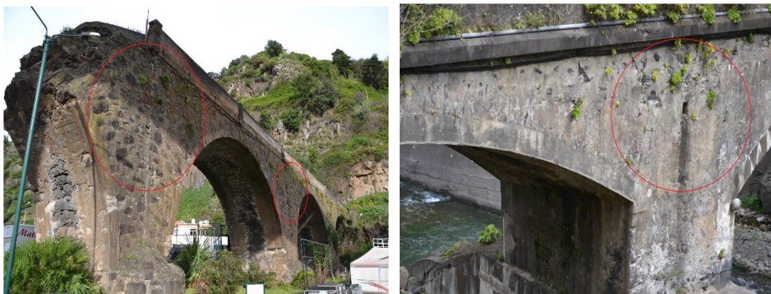
Figura 11 – Muros de tímpano; Ponte do Faial (esq.); Ponte Estrada Dr. João Abel (dir.);
