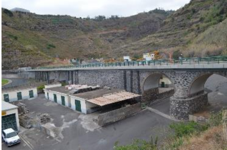
Fotografia 1 – Alçado Jusante (esq.);
