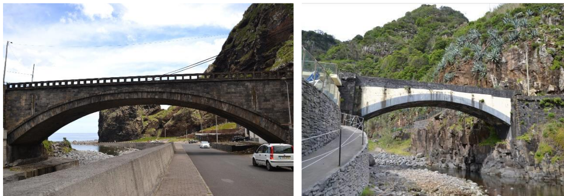
Figura 13 – Arcos abatidos da Ponte Antiga ER 101 Ribeira da Janela (esq.); Ponte Ramal do Caminho Real Nº23 (dir.);
