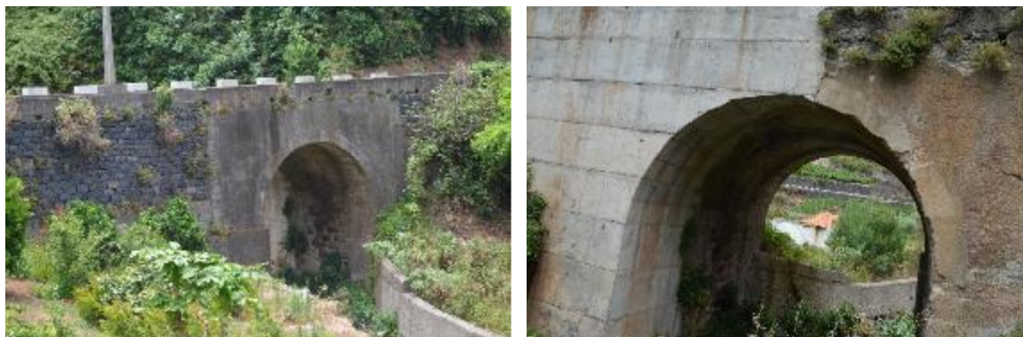
Fotografia 1 – Alçado Jusante (esq.); Alçado Montante (dir.)
