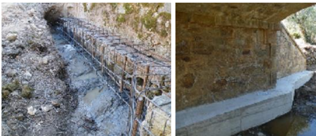
Figura 42 – Execução de viga de embasamento, nos apoios da ponte [12];
