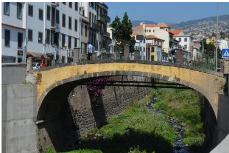
Fotografia 1 – Alçado Jusante (esq.);
