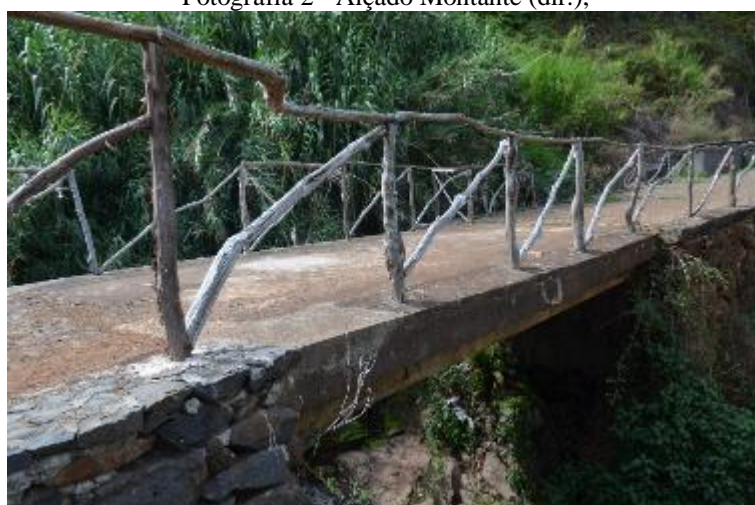
Fotografia 3 – Pavimento e Guarda Corpos;
