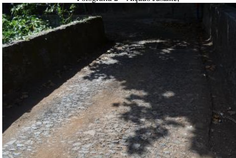
Fotografia 3 – Pavimento e Guarda Corpos;
