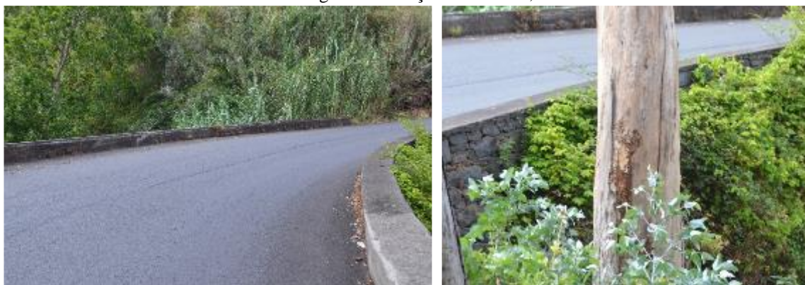
Fotografia 3 – Pavimento, Guarda Corpos; Pormenor Alvenaria de Pedra a Montate;
