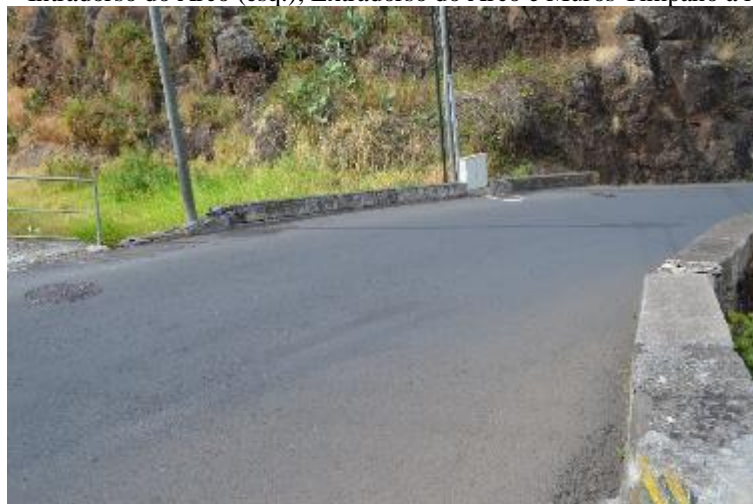
Fotografia 3 – Pavimento e Guarda Corpos;
