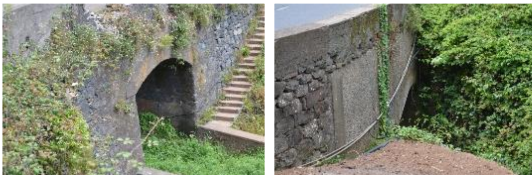
Fotografia 1 – Alçado Jusante (esq.); Alçado Montante (dir.);
