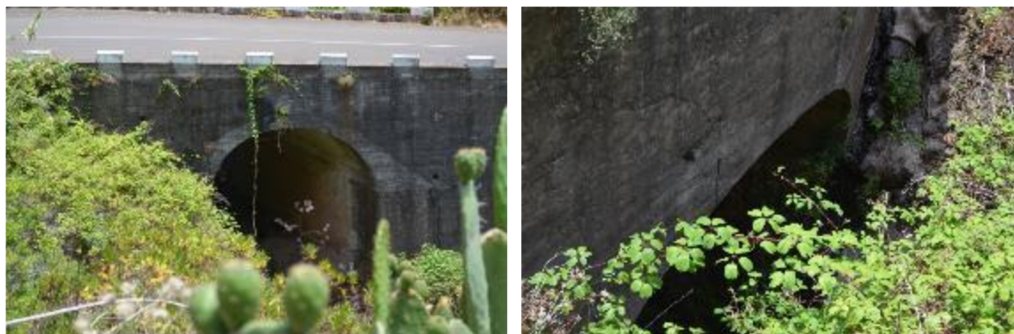
Fotografia 1 – Alçado Jusante (esq.); Alçado Montante (dir.);
