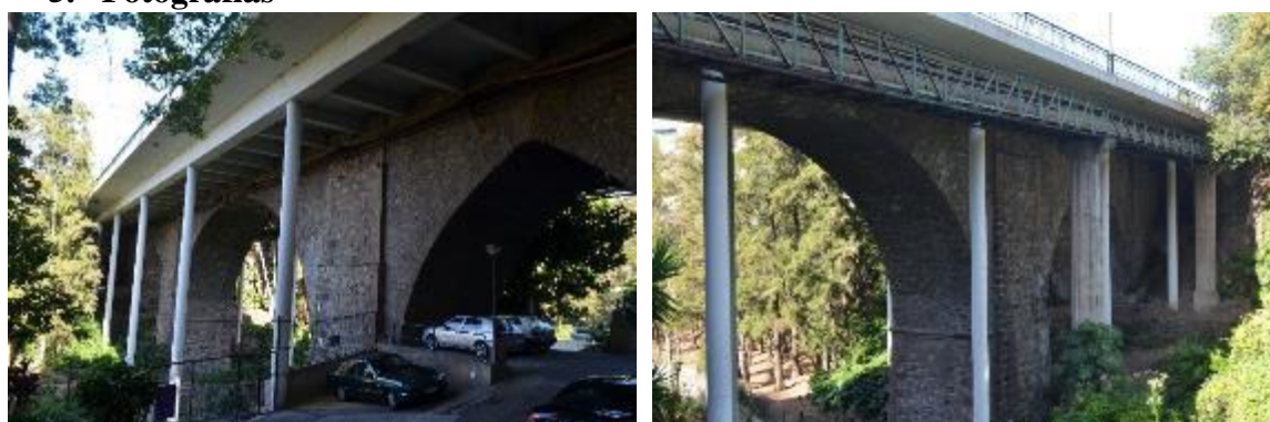
Fotografia 1 – Alçado Montante (esq.); Alçado Jusante (dir.);
