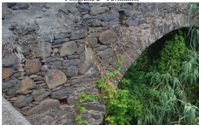
Fotografia 3 – Encontro, Muro de Tímpano, Extradorso e Intradorso do Arco;
