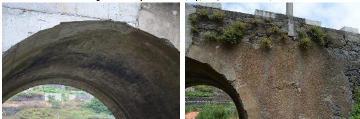
Fotografia 2 – Extradorso e Intradorso Arco (esq.); Muro Tímpano e Encontro (dir.);
