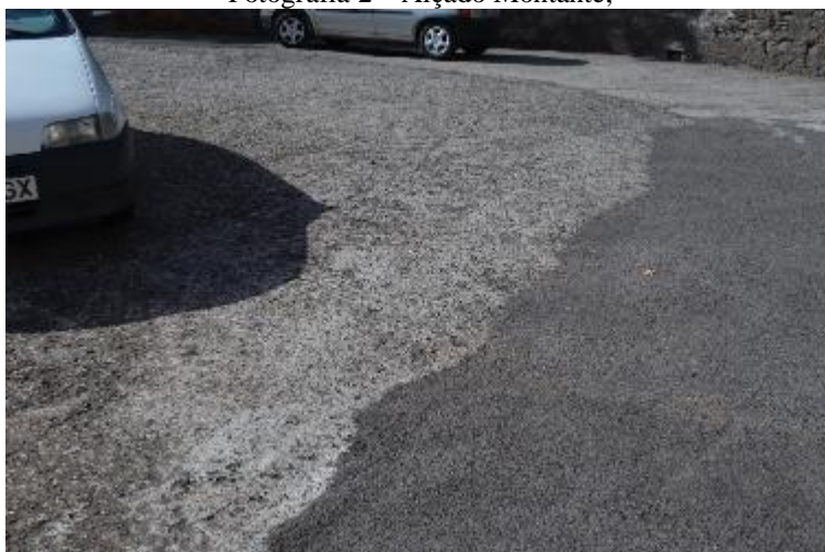
Fotografia 3 – Pavimento numa camada de betão e betuminoso;
