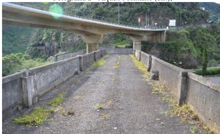
Fotografia 3 – Pavimento e Guarda Corpos;
