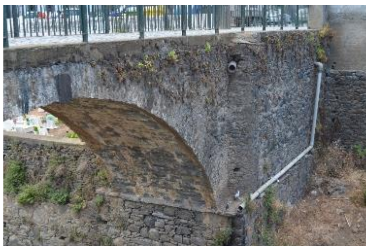
Fotografia 2 – Extradorso, Intradorso do Arco, Muro de Tímpano e Encontro;
