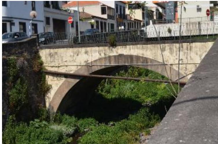
Fotografia 1 – Alçado Jusante (esq.);
