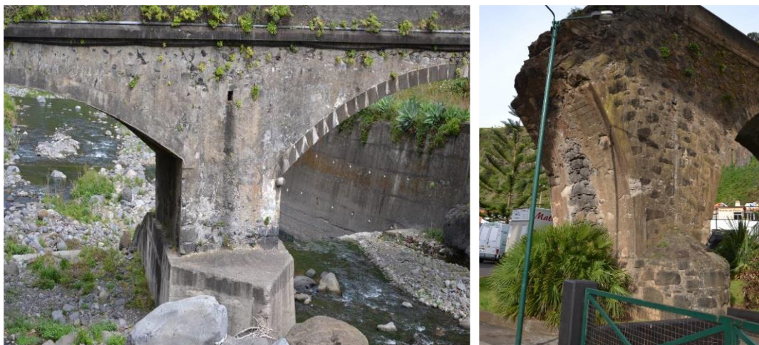
Figura 17 – Pilar da Ponte Estrada Dr. João Abel (esq.) e da Ponte do Faial (dir.);
