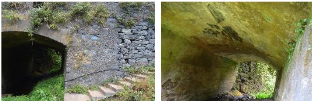
Fotografia 2 – Extradorso do arco, Muro Tímpano (esq.); Intradorso do arco (dir.);
