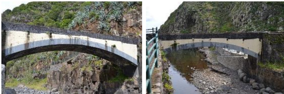
Fotografia 1 – Alçado Jusante (esq.); Alçado Montante (dir.)
