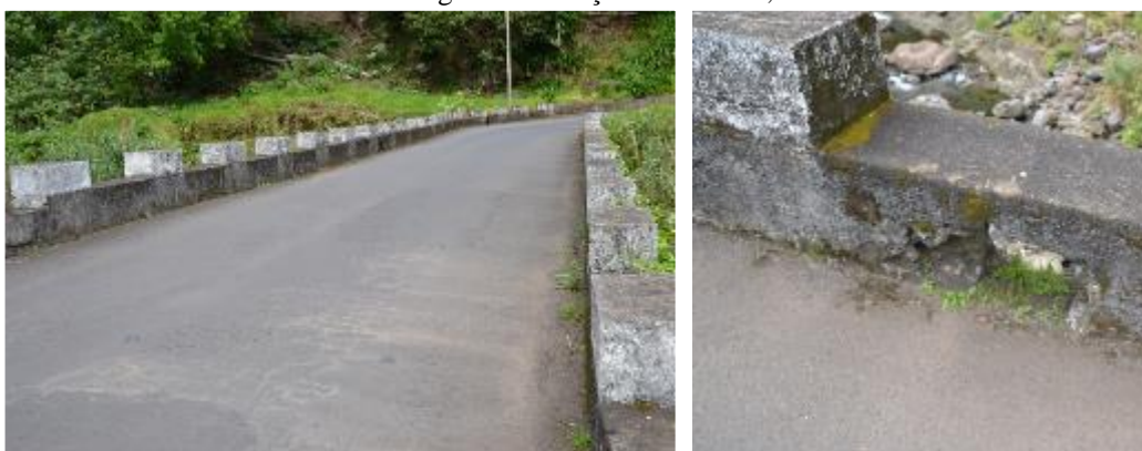
Fotografia 3 – Pavimento (esq); Pormenor Guarda Corpos (dir.);
