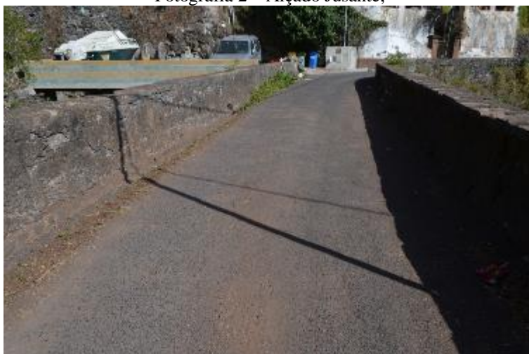
Fotografia 3 – Pavimento e Guarda Corpos;
