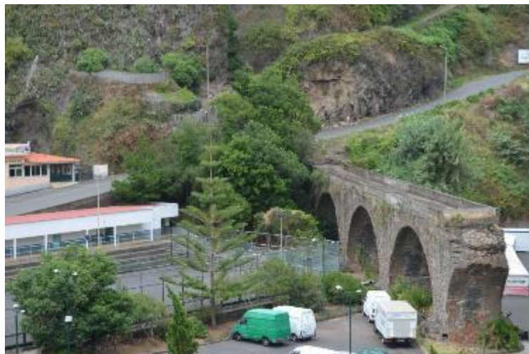
Fotografia 1 – Alçado Jusante (esq.);
