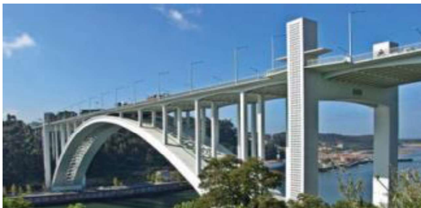
Figura 9 Ponte da Arrábida, 1963, Edgar Cardoso Fotografia, [s.d] (Douro, s. d.)
