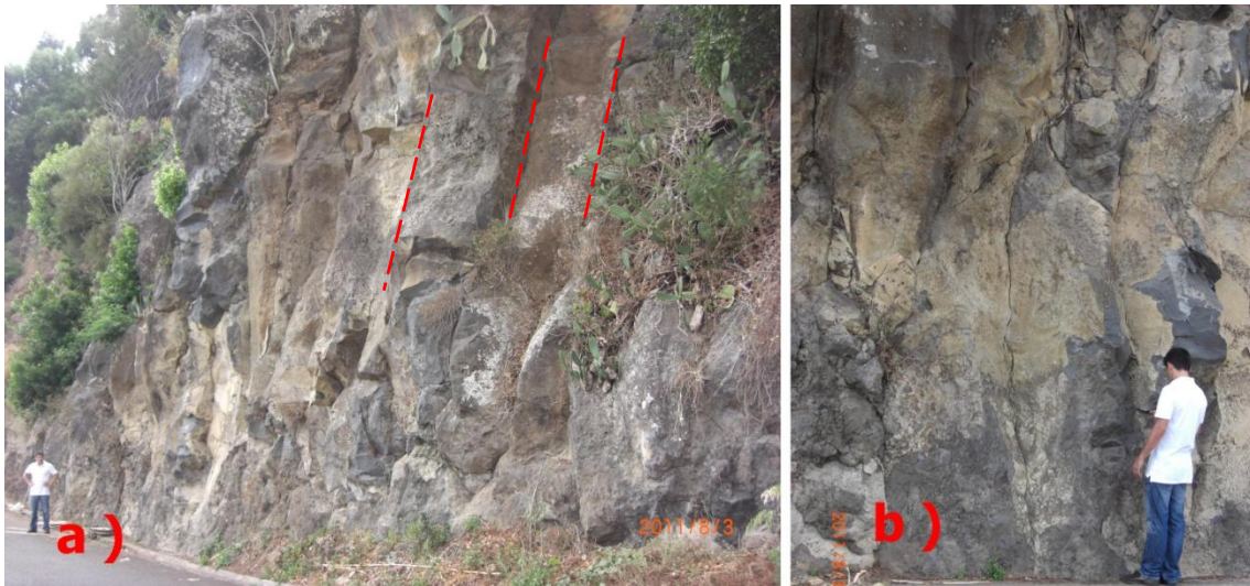
Figura 51 – a) Vista do afloramento basáltico com as descontinuidades assinaladas; b) Pormenor do afloramento com boa percepção das descontinuidades.
