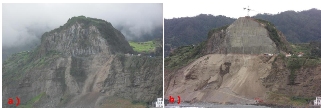
Figura 15 – a) Arriba costeira em fase inicial de obra; b) Arriba costeira em fase intermédia de obra.
