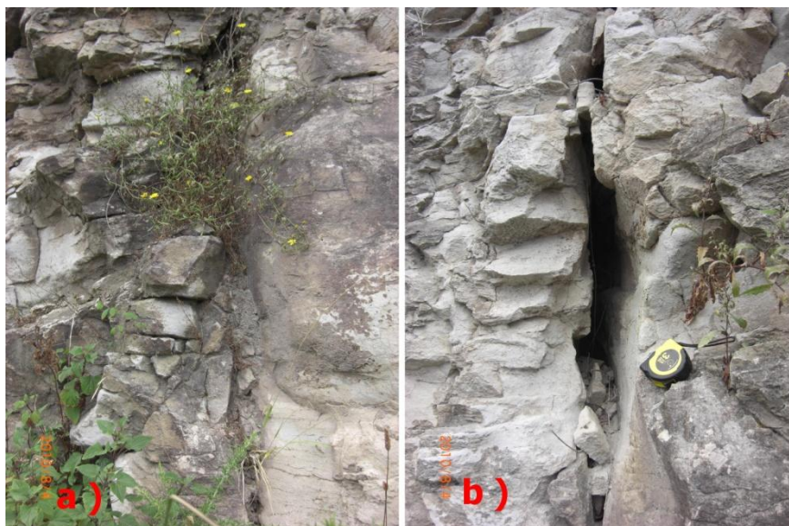
Figura 50 – a) Pormenor de uma espessura da família F5-b , preenchida com terra vegetal/matéria orgânica e material argiloso; b) Pormenor de uma abertura da família F5-b .
