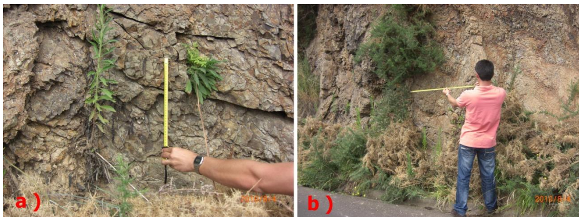
Figura 44 – a) Momento da medição do espaçamento das fracturas da família F1-a ; b) medição do espaçamento das descontinuidades da F1-b .
