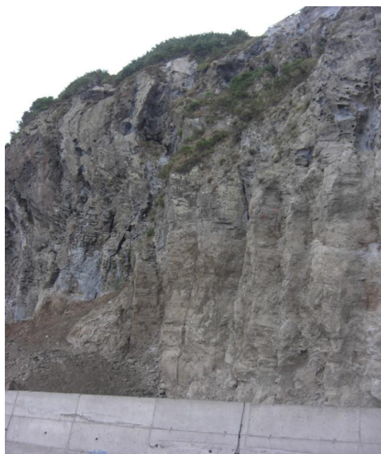
Figura 47 – Afloramento inacessível de rocha mugearítica, fotografado a cerca de 25 metros da parede rochosa, de onde se pode ver o coroamento do muro de suporte.
