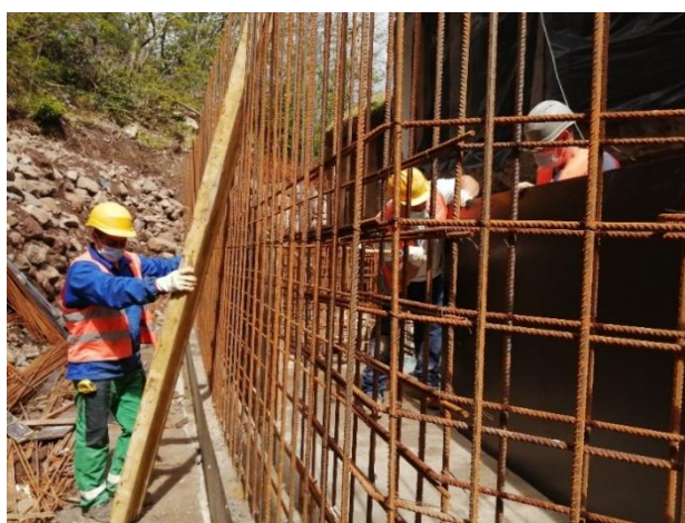
Figura 7 – Trabalhos de cofragem em tempos de Covid-19.
