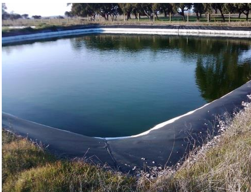
Figura 27 - Sistema de tratamento biológico por lagunagem
