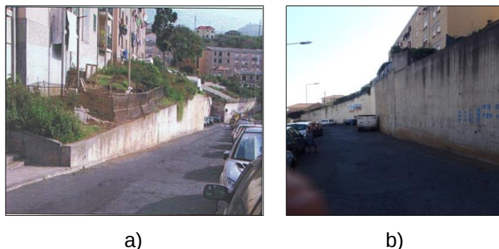
Figura 59 - Muros de suporte: a) Muro "M16"; e b) Muro "M11".
