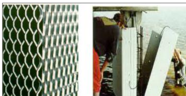
Figura 40 - Malha de zinco e colocação dos encamisamentos de fibra de vidro (Silva, 2007).
