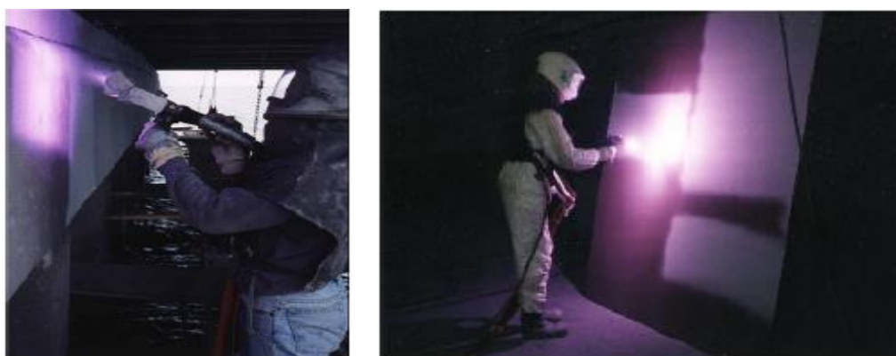
Figura 41 - Aplicação de metais por projecção sobre uma estrutura de betão armado (Silva, 2007).
