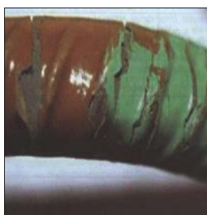
Figura 53 - Corrosão devido a ruptura da película de resina numa armadura (Polito, 2006).
