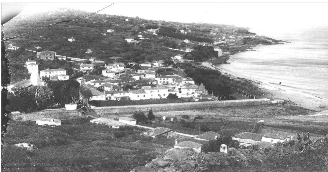
Imagem 1. 1 – Vista de Santa Cruz (São Fernando) (fotografia pertença de Ezequiel Vieira)
