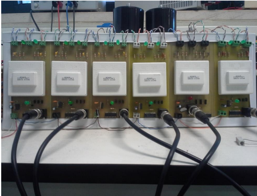
Fig. G.9 – Fotografia dos circuitos elétricos de comando dos semicondutores de potência do conversor multinível.
