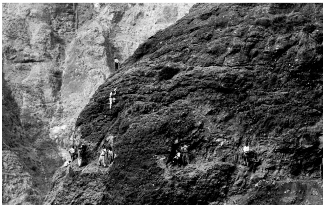
Figura 19: Construção da Levada do Norte. Fonte: https://acesse.one/madeira
