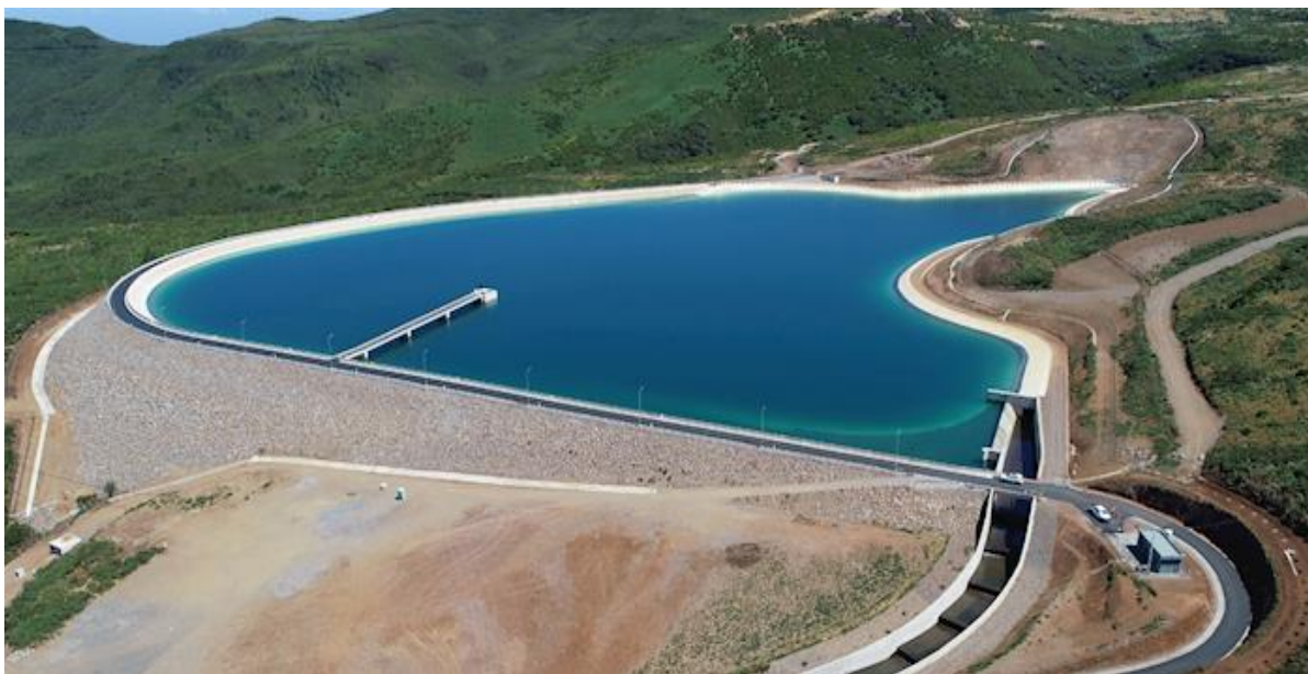
Figura 5: Central Hidroelétrica da Calheta III. Fonte: https://11nq.com/poseur-pt
