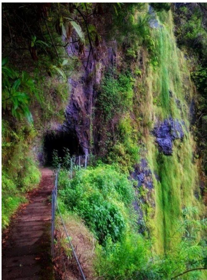
Figura 18: Túnel da Levada Fajã do Rodrigues, São Vicente. Fonte: acervo próprio.
