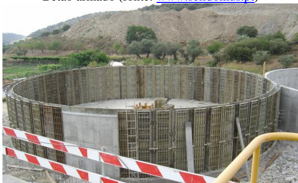
Betão armado (fonte: www.selidomus.pt )
