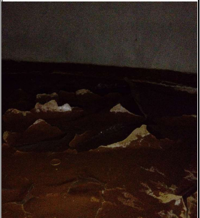
Figura 4 - Laje de fundo
