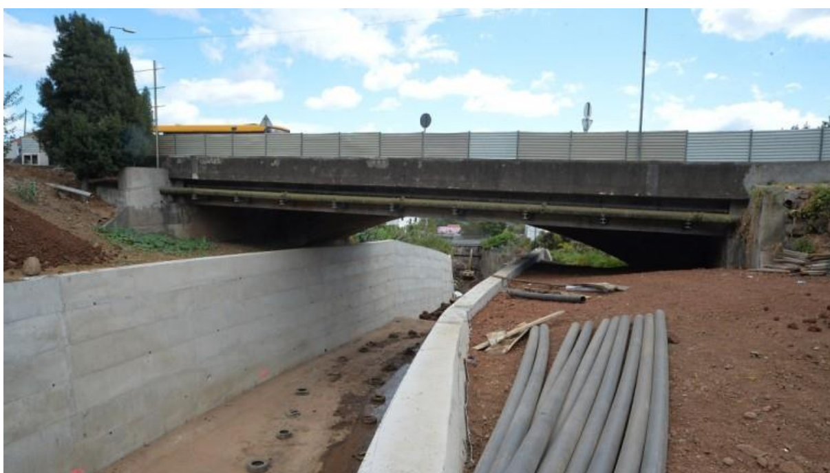
Figura 2 – Obra de recuperação (fonte: Silva, 2016)
