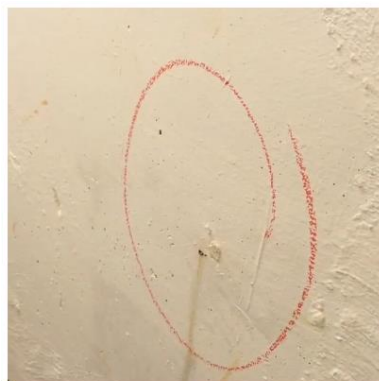
Figura 60 – Detecção de uma fuga durante um teste de estanquicidade (fonte: www.construcaocivil.info )
