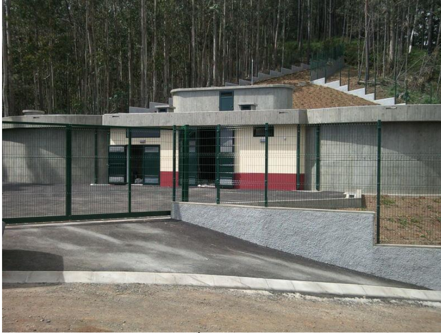
Figura 8 – Reservatório das Águas Mansas (fonte: www.socopul.pt )
