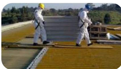
Remoção de Fibrocimento
