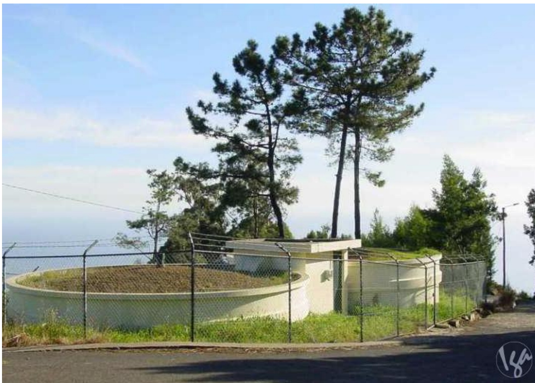
Figura 1 – Reservatório da Apresentação, Ribeira Brava (fonte: www.aguasdmadeira.pt )
