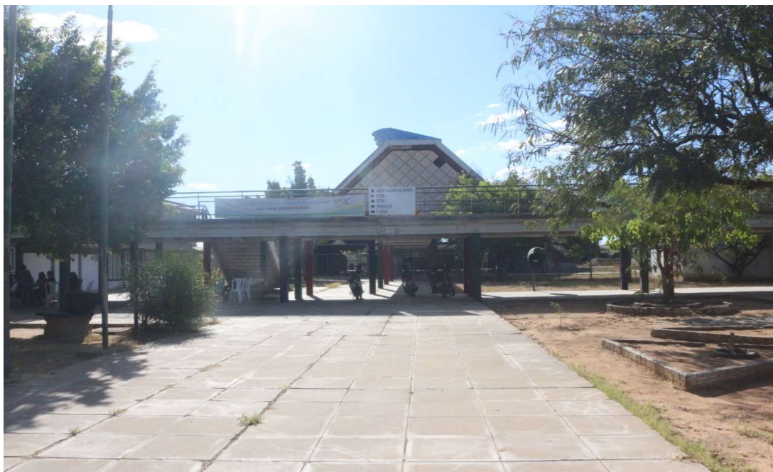
FOTO 27: FACHADA DA ESCOLA
