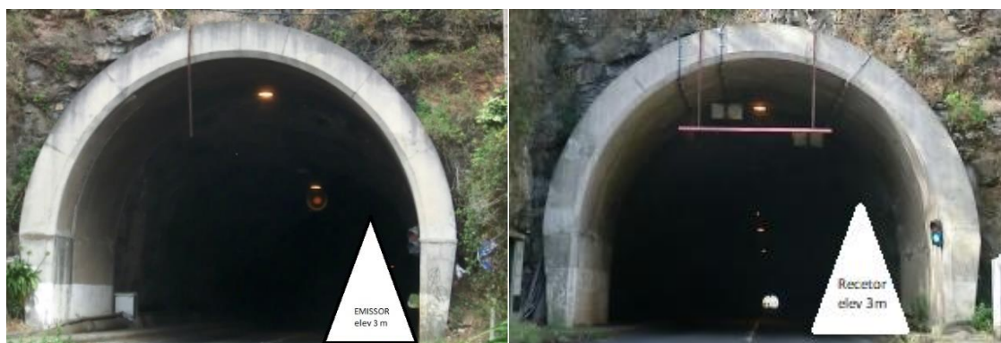
Figura 4.24 - Túnel do Caniçal (pontos de colocação dos protótipos de teste).
