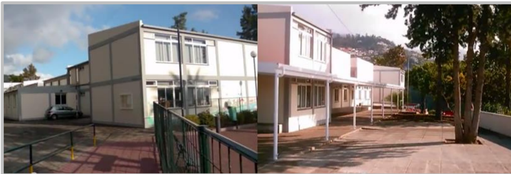
Figura 17. Espaços exteriores da EB1/PE do Lombo Segundo
