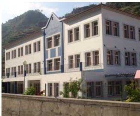
Figura 10. O Edifício escolar da EB1/PE de Santa Cruz.
