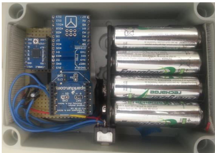
Figura 3.28. Caixa estanque com circuito elétrico implementado.
