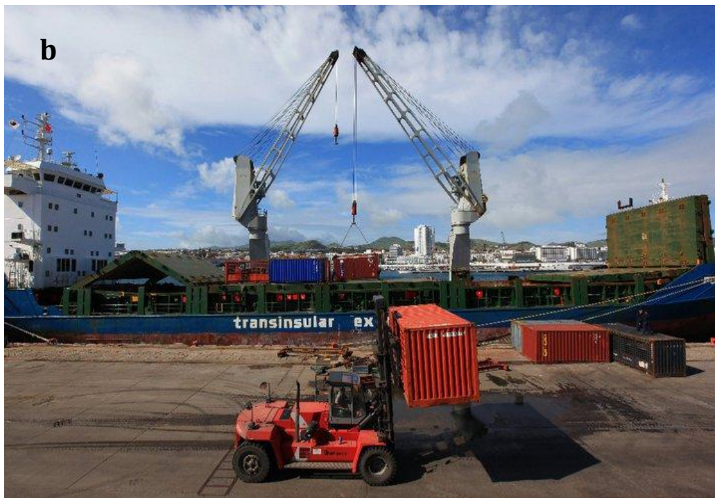
Figura B.2 – a) e b) Operações no molhe do cais comercial de Ponta Delgada (Fonte: Google).
