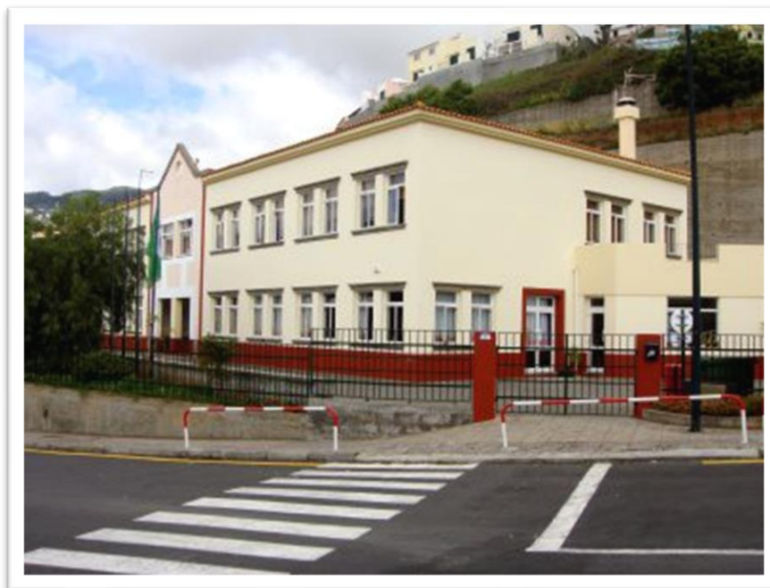
Figura 25 - Fachada da EB1/PE das Figueirinhas
