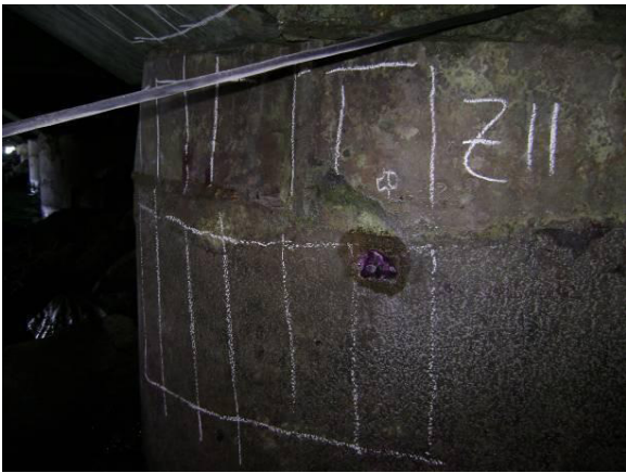
Fig. 43 – Zona de ensaios Z11 em pilar. Idem.
