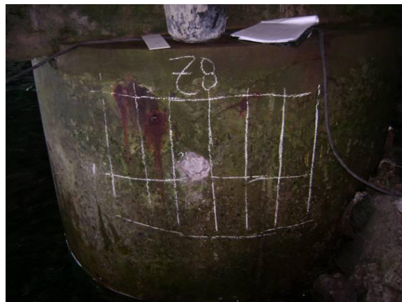
Fig. 40 – Zona de ensaios Z8 em pilar. Idem.
