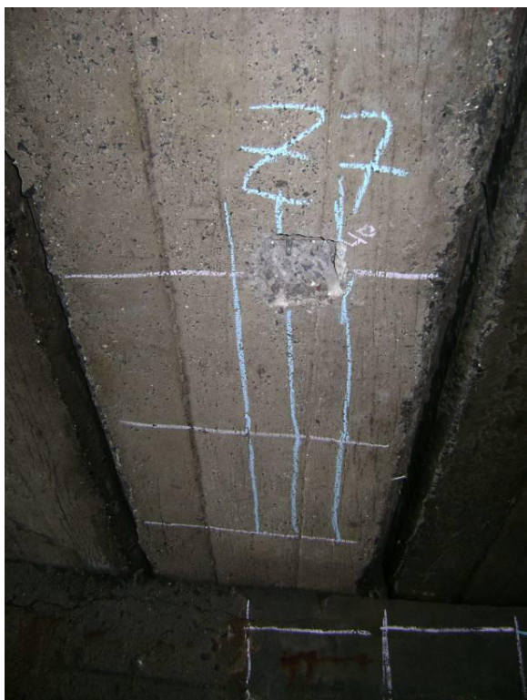
Fig. 39 – Zona de ensaios Z7 na face inferior da viga pré-fabricada da laje. Idem.
