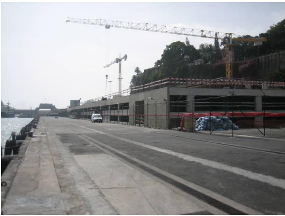
Fig. 1 – Vista geral da ponte cais.
