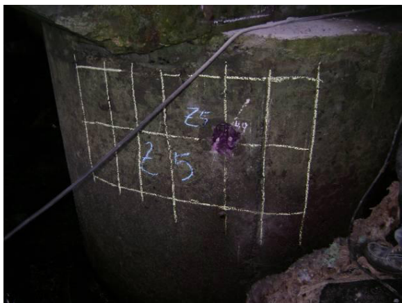
Fig. 37 – Zona de ensaios Z5 em pilar. Idem.
