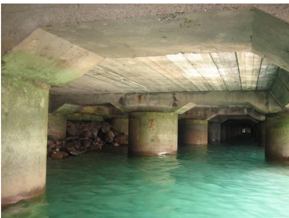
Fig. 3 – Vista inferior do tabuleiro.
