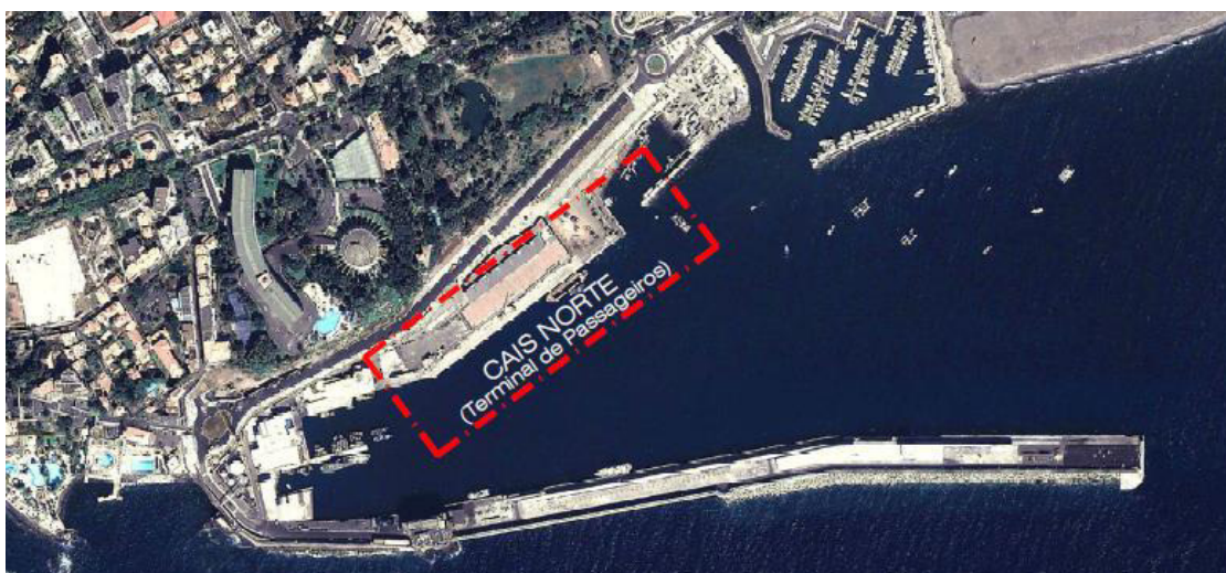
Figura 3.5 – Imagem aérea da área de construção fornecidas pela APRAM
