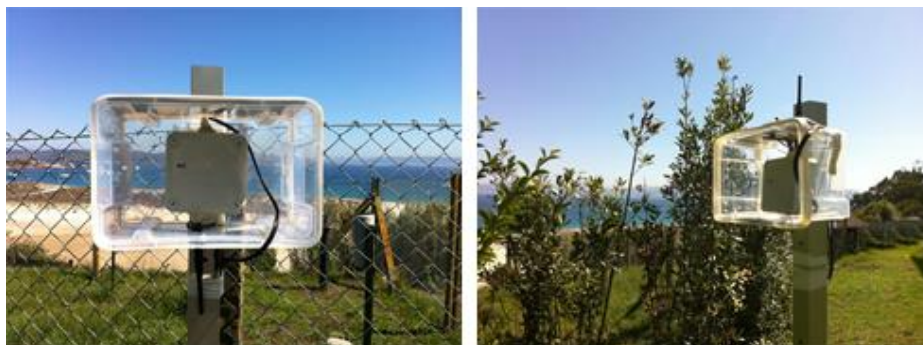
Figura 2.23 - Ilustração dos nós sensores no terreno.
