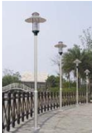
Figura 2.8 – Antena camuflada num poste de iluminação.
