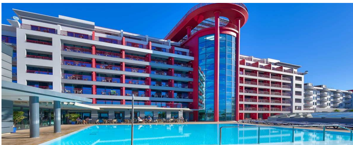
Figura 8 Instalações do hotel The Views Monumental
