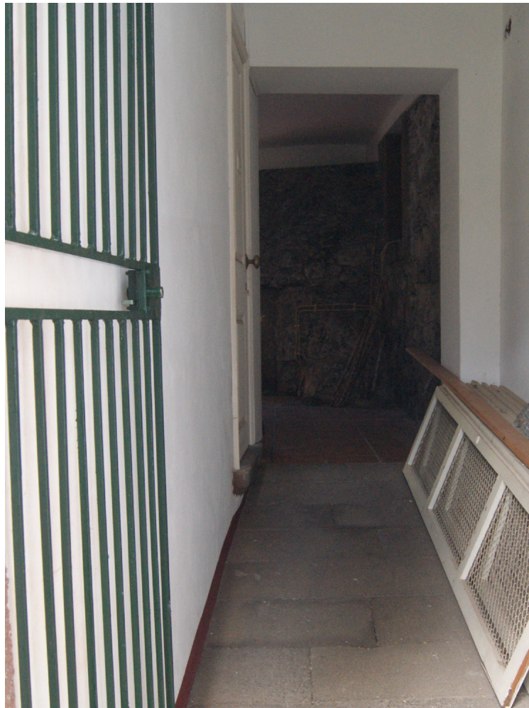
Fig.148 - Túnel de acesso ao jardim (5 de Maio de 2020).
