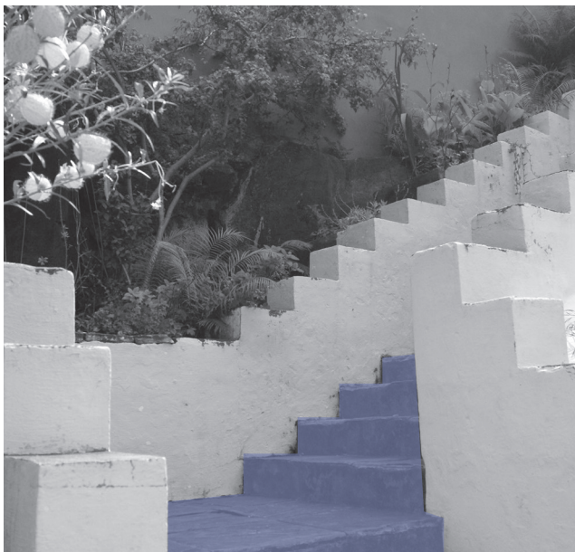
Fig.93 - Escadas de acesso ao interior do equipamento.
