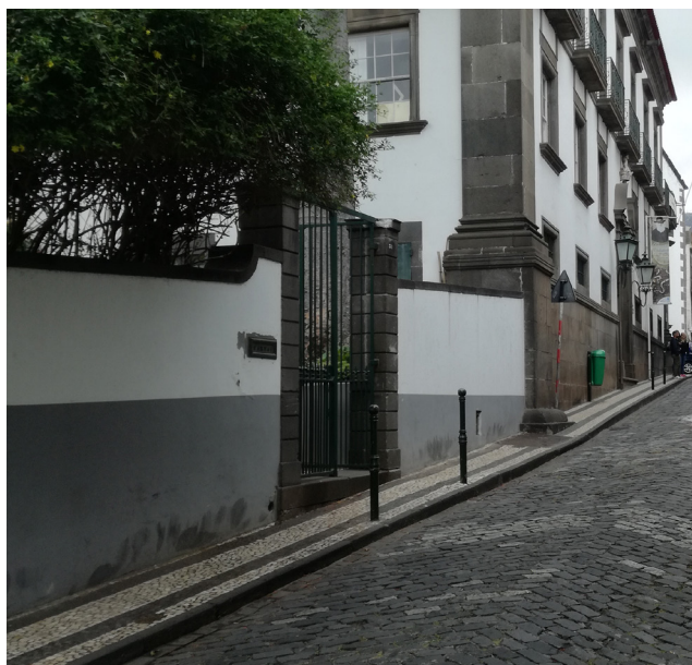
Fig.75 - Portão de acesso ao jardim (vista do exterior).
