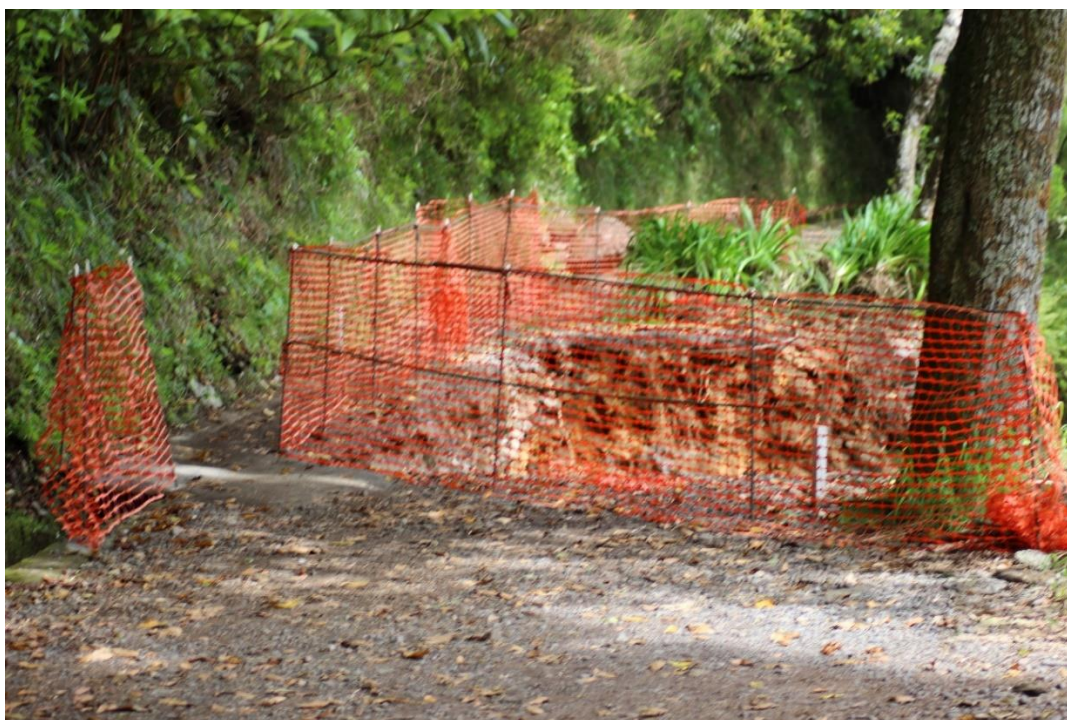
Figura 12: Trabalhos de reparação do percurso após uma derrocada Fonte Marcos Mateus
