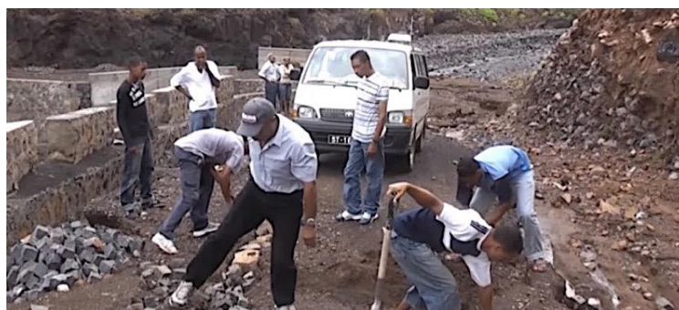
Figura 51 - Reconstrução de via rodoviária
