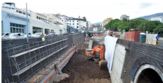
Figura 29 – Obras de regularização da ribeira de Santa Luzia
