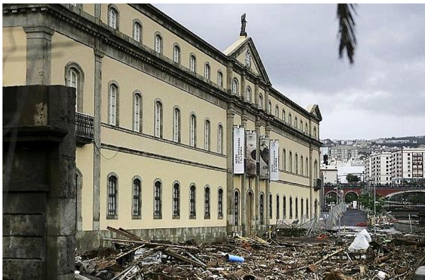
Figura 45 - Entulho na rede viária resultante do extravasamento do barranco Santos Fonte: Mail Online, 2010.
