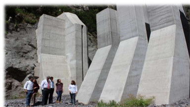
Estruturas de Contenção (Açudes)
