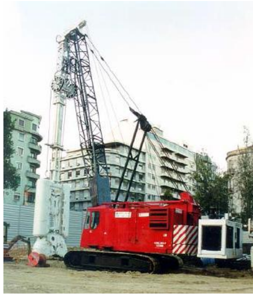
Figura 2.16 - Equipamento utilizado para a escavação - Grab hidráulico (Tecnasol FGE, 2008)
