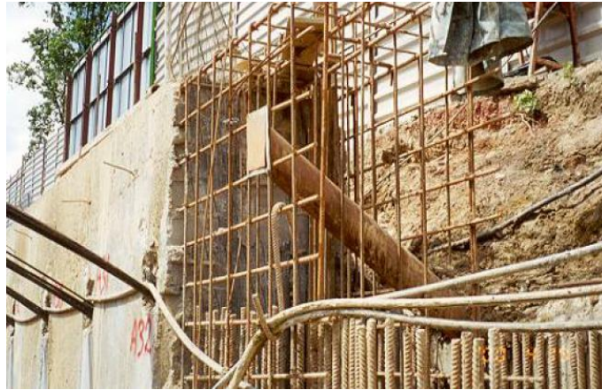
Figura 2.18 - Execução da viga de coroamento e negativo de ancoragem (Tecnasol FGE, 2008)
