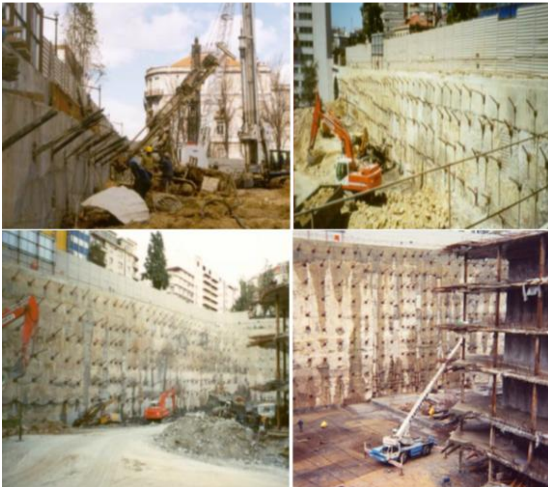
Figura 2.19 - Algumas fases de construção da obra (Tecnasol FGE, 2008)
