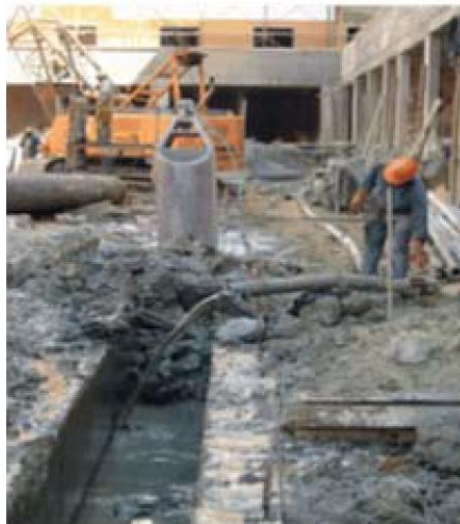
Figura 2.6 - Bombagem de lama bentonítica para a vala
