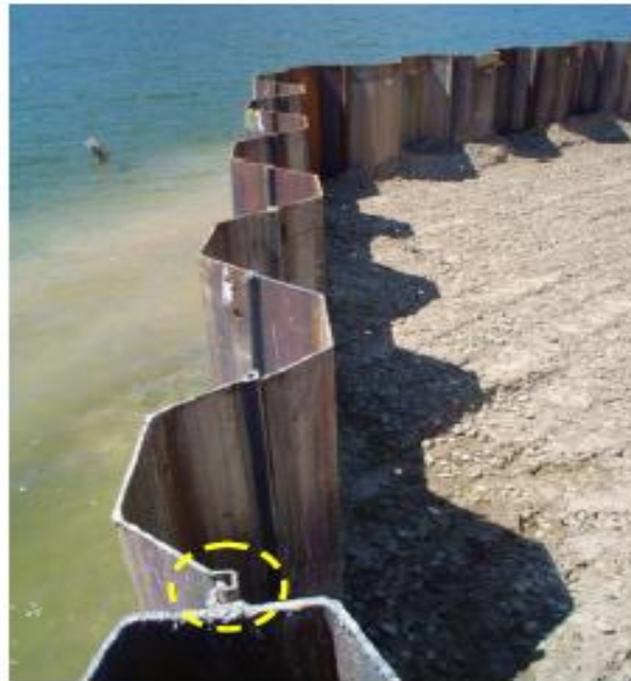
Figura 2.23 - Cortina de estacas-prancha (Aguiar, et al., 2005)
