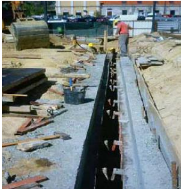
Figura 2.5 - Execução de um murete guia
