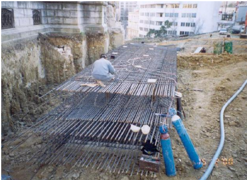
Figura 2.17 - Preparação das armaduras (Tecnasol FGE, 2008)
