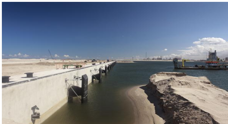
Figura 2.21 - Escavação da areia a jusante da parede moldada (Port of Rotterdam Authority, 2012)
