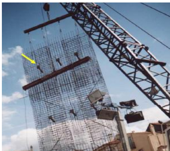
Figura 2.7 - Elevação da gaiola de armaduras com destaque para o negativo da ancoragem (Lança, 2008)
