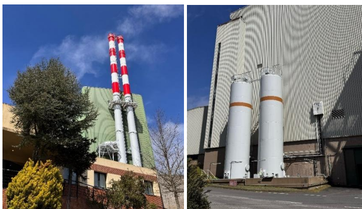
Figura 25 – Estação de Tratamento de Resíduos Sólidos (ETRS) da Meia Serra.
