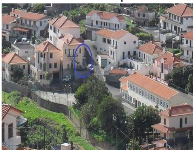
Figura 25: Edf. do CCCS-RS. (ft. do próprio, 07/05/2022)
