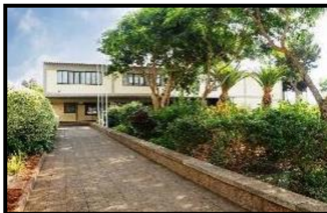
Figura 46. EB1/PE do Tanque – Santo António
