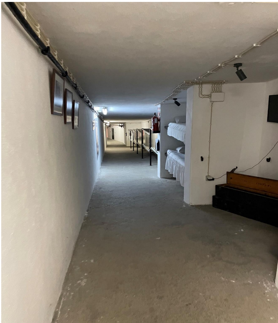
Fig. 27. Galerias subterrâneas de apoio à Bateria de Costa do Pico da Cruz com as tarimbas destinadas ao pessoal de serviço. Foto Tânia Freitas.
