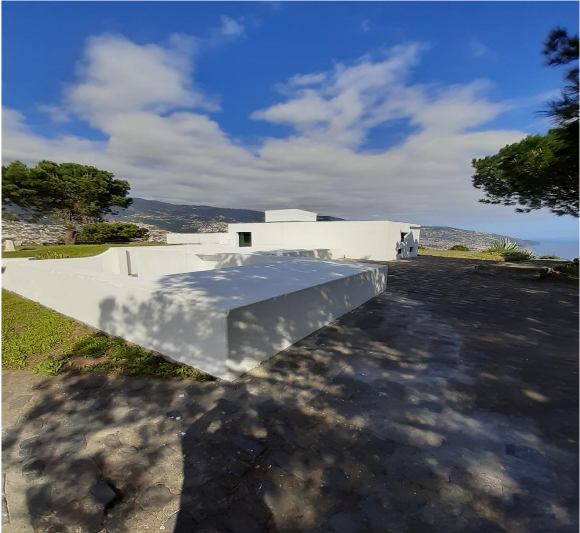
Fig. 38. Vista do posto de comando das baterias antiaéreas, após obras de recuperação. Foto do autor.
