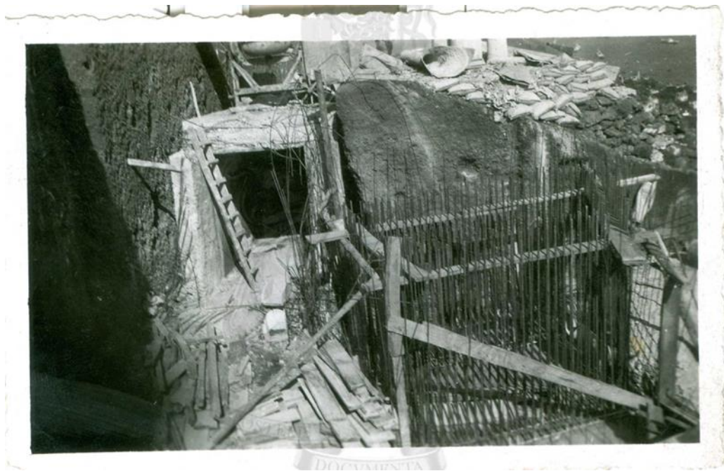
Fig. 24. Construção das galerias subterrâneas de apoio à Bateria de Costa, 1940. Fonte: Arquivo Histórico Militar. PT/AHM/FE/110/D4/PQ/3.
