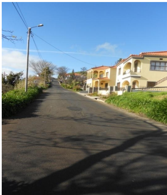
Figura 34 – Estrada Regional – Lombada dos Marinheiros
