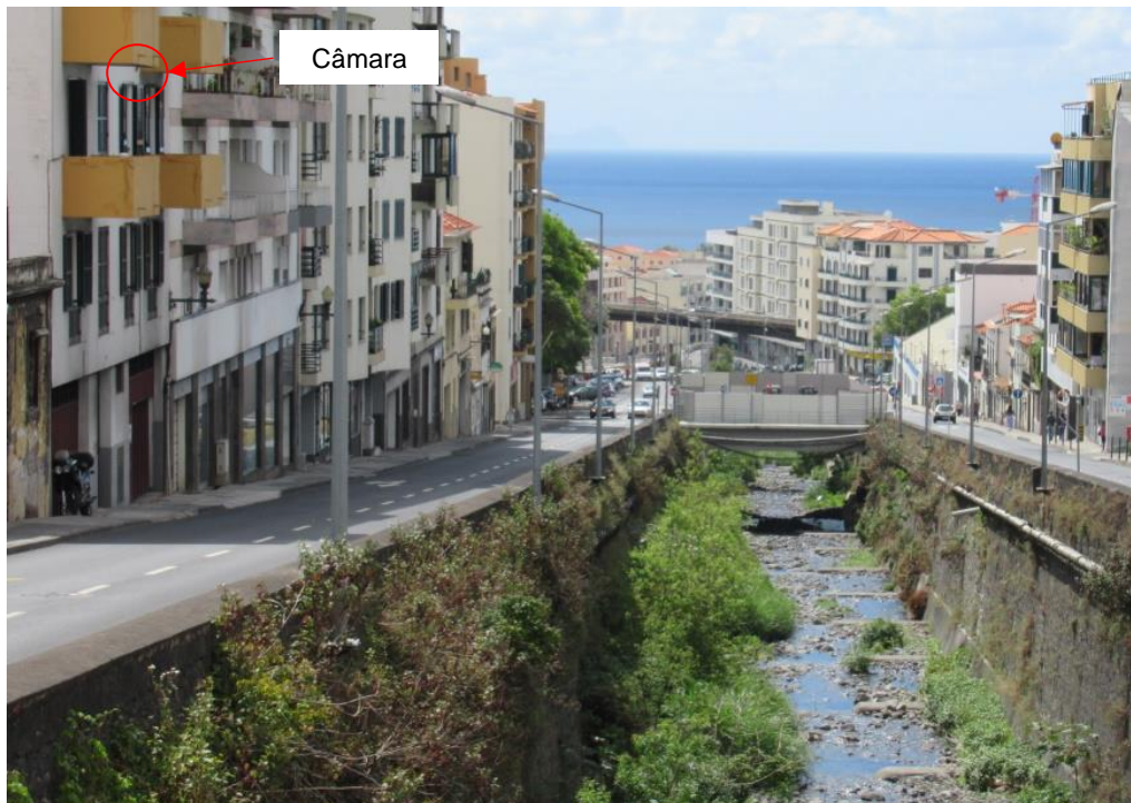
Figura 3.1 - Sistema de aquisição de imagem instalado na ribeira de Santa Luzia.
