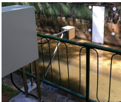
Figura 2.5 - Instalação do sistema no canal pluvial [14].
