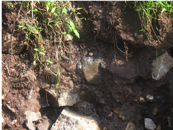
Figura 8.1 – Pode-se observar a água presente no solo superficial.
