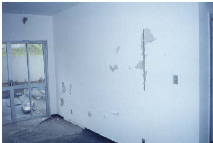
Figura 2.13 – As estacas de fundação acompanharam o assentamento do prédio, o piso do primeiro pavimento está praticamente intacto, inclusive com o acabamento de ardósia, que não sofreu maiores danos (Maffei Engenharia, Gimenez de Souza, 2003).
