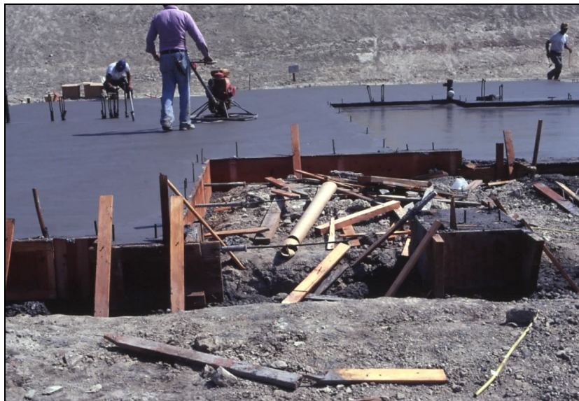
Figura 10.5 – Execução de um ensoleiramento Geral (Rogers, 2003).
