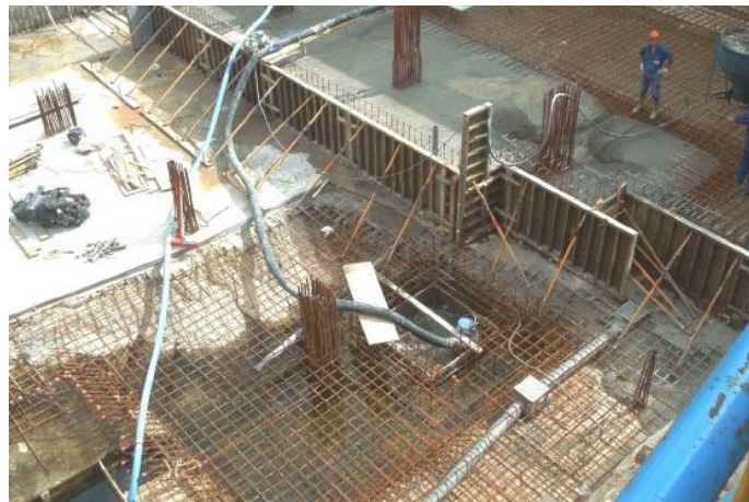
Figura 3.2 – Redução do nível freático com ajuda de bombas durante a betonagem (Fritz, 2009).
