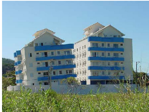
Figura 2.11 - Deslocação sofrida do bloco “B” do condomínio “Anêmona” (Maffei Engenharia, Gimenez de Souza, 2003).
