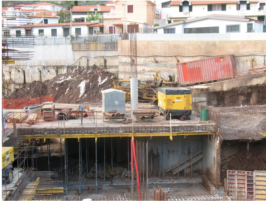
Figura 8.7 – Muros de contenção da obra.
