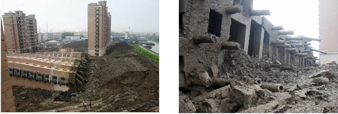
Figura 4.4 – A) e B) imagens do desabamento do prédio em Xangai (Foncillas, 2009).
