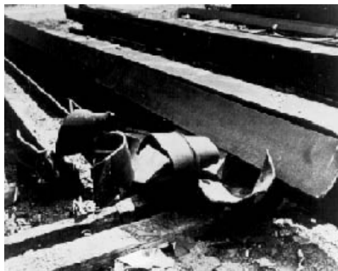
Figura 3.9 – Danos em estacas metálicas (Schnaid et al., 2005).
