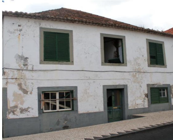
Fotografia 1 – Imóvel onde funcionou a sede do CIPM, na Rua do Ribeirinho, 21 – Machico. (Foto João Bernardo Martins, 2015)
