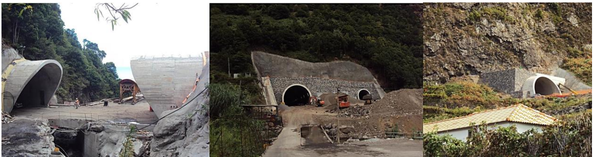
Figura 11: Tipos de emboquilhamentos a) (Mascarenhas, 2011) b) (RAMEDM, 2011)
