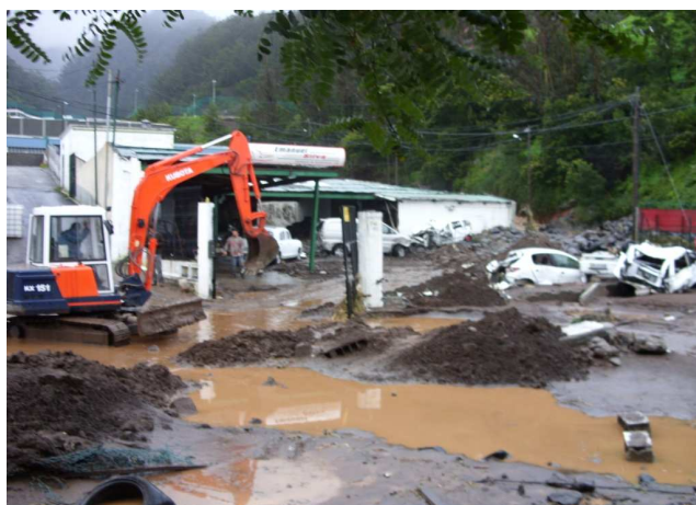
Figura 53 - Armazéns inundados no Caminho da Ribeira Grande Fonte: João Perneta
