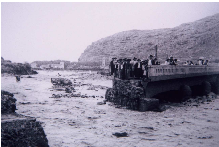
Figura 19: Ponte destruída na Ribeira de Machico Fonte: Perestrellos Photographos, Museu “Vicentes”
