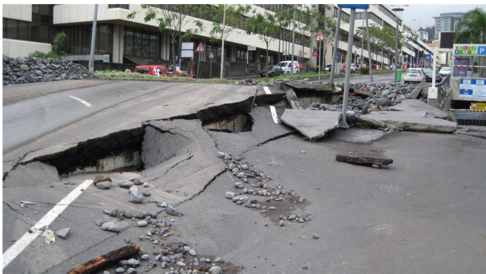
Figura 64: Laje de cobertura da Ribeira danificada Fonte: SRES
