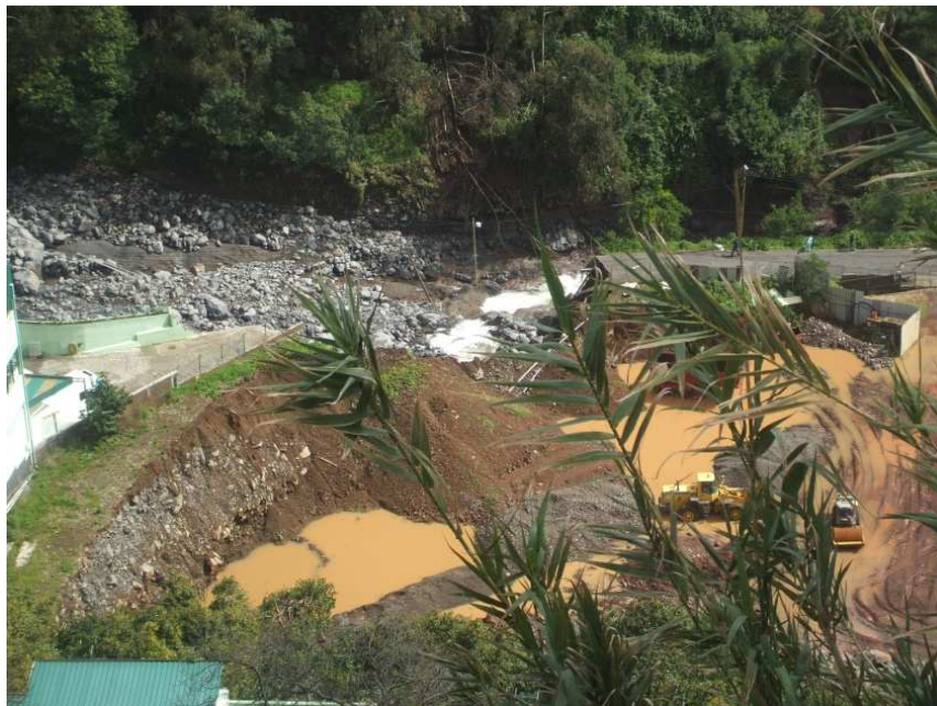
Figura 61: Estrada destruída no Caminho da Ribeira Grande, Santo António Fonte: Desconhecido
