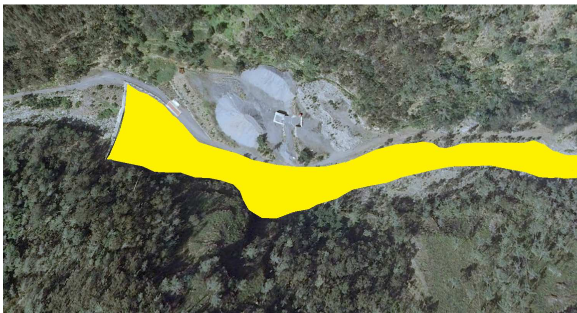
Figura A.2.9: Área de deposição de material sólido no leito da Ribeira a montante da barragem de retenção
