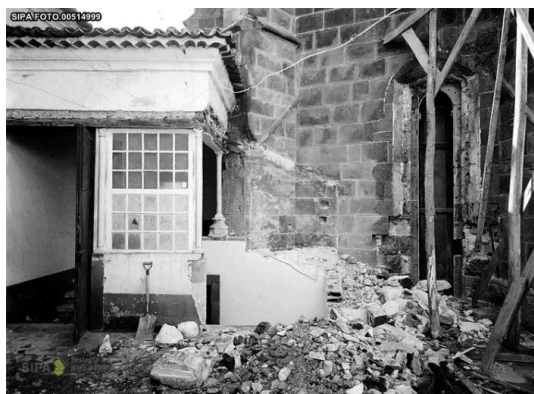
Figura 30 - Demolição dos anexos pertencentes às confrarias (fonte: SIPA).
