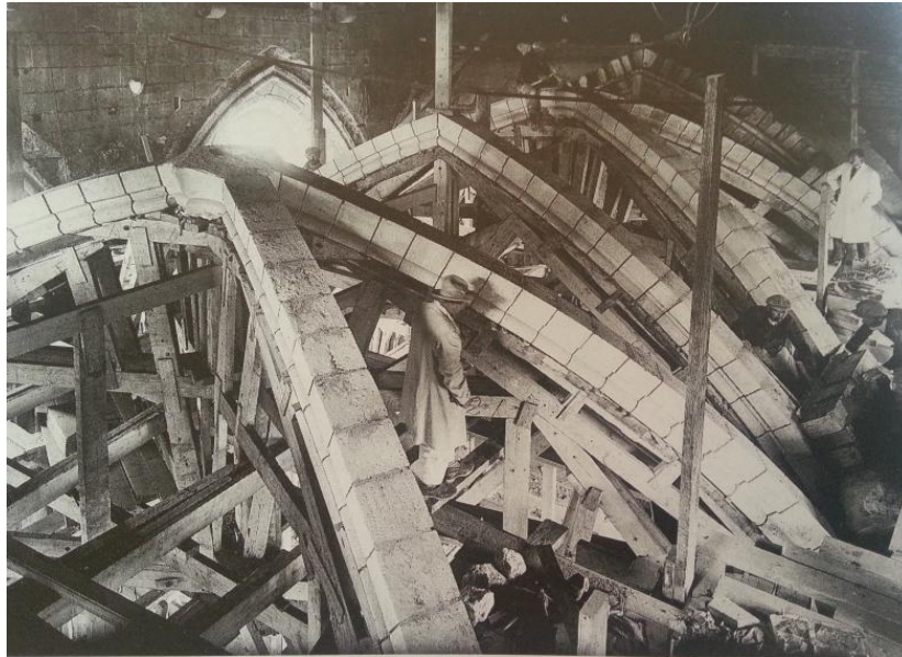
Figura 8 - Método construtivo de uma abóbada (7).
