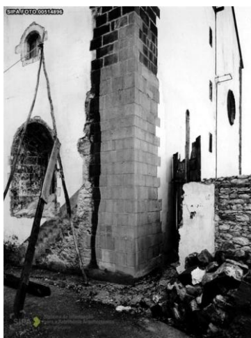
Figura 31 - Consolidação do cunhal da Torre Sineira (fonte: SIPA).
