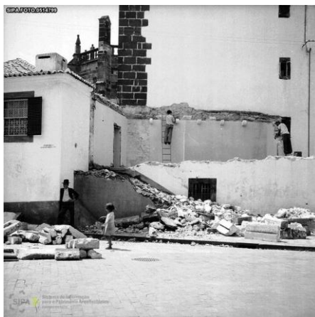
Figura 29 - Demolição da arrecadação anexa à Torre (fonte SIPA).
