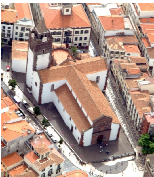
Figura 20 - Vista aérea da Sé do Funchal (fotografia DRAC).
