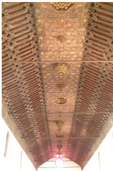
Figura 14 - Teto da nave central da Sé do Funchal (fotografia DRAC).
