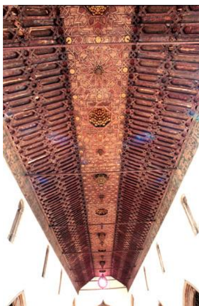
Figura 24 - Teto da nave central (fotografia DRAC).
