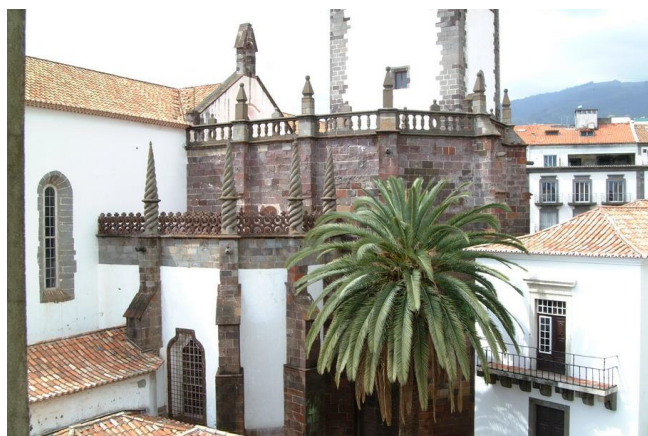
Figura 27 - Vista exterior da cabeceira (fotografia DRAC)
