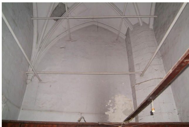
Figura 28 - Tirantes da sala do piso 2 da torre
