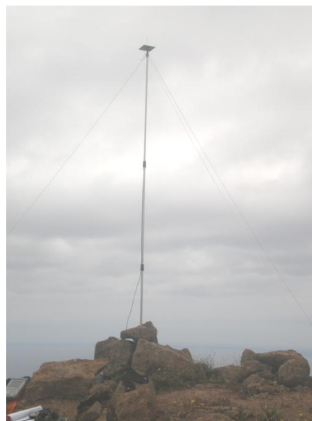
Fig. 6 Mastro montado com a antena, fixo por 3 espigas
